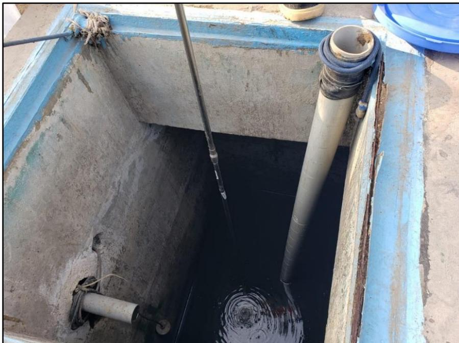
**Foto 3.** Medición de parámetros in situ del agua residual de la PTAR de la municipalidad de Independencia.
