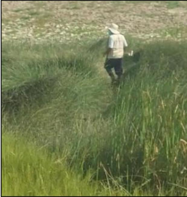
**Foto 6.** Adición del sustrato zeolita al humedal artificial subsuperficial de flujo horizontal.
