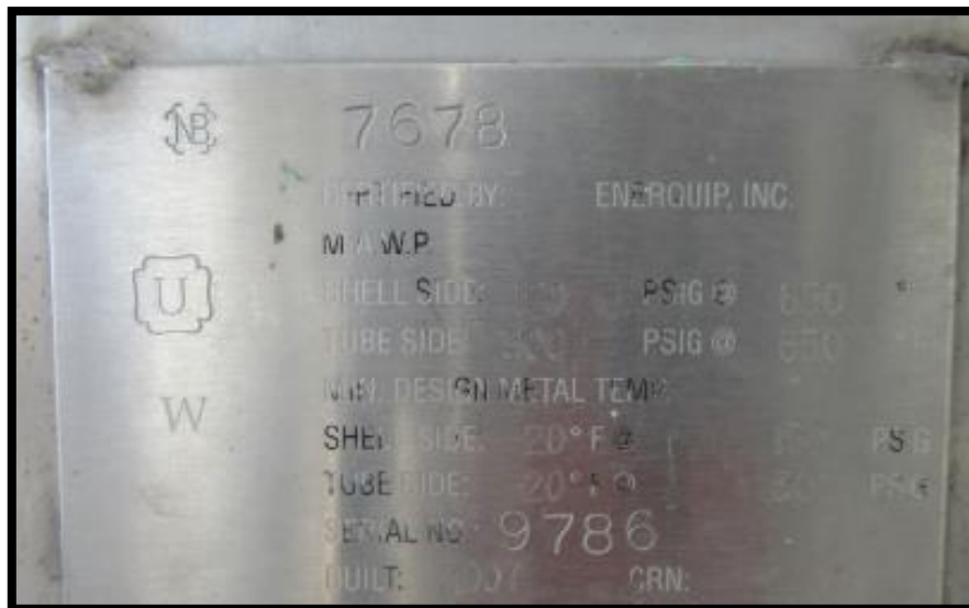
Fotografía 5 Presión de Diseño de Intercambiador de Tubo y Coraza: 150Psig lado Coraza; 300Psig lado tubo.
