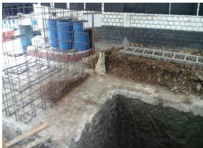
Obras realizadas en la zona 1
