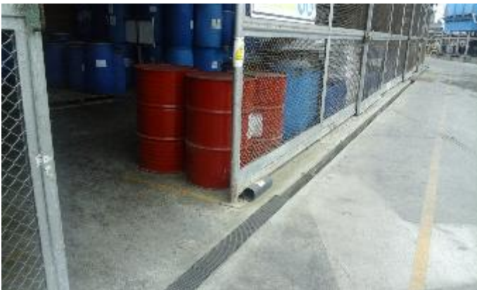
Colocación de canaletas en la zona 3
