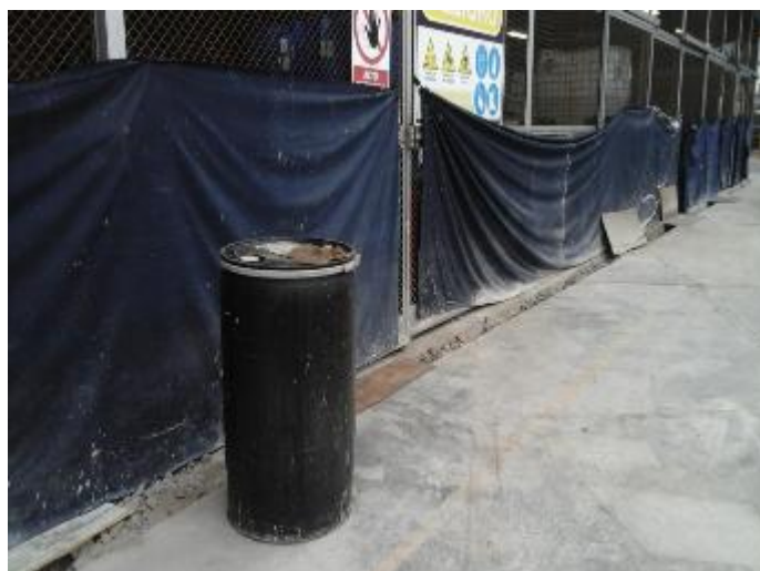
Obras realizadas en la zona 3
