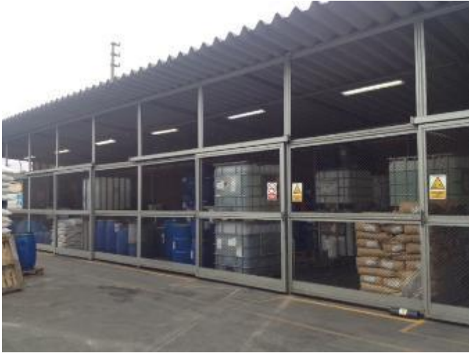
Almacén sin sistema de contención de derrame
