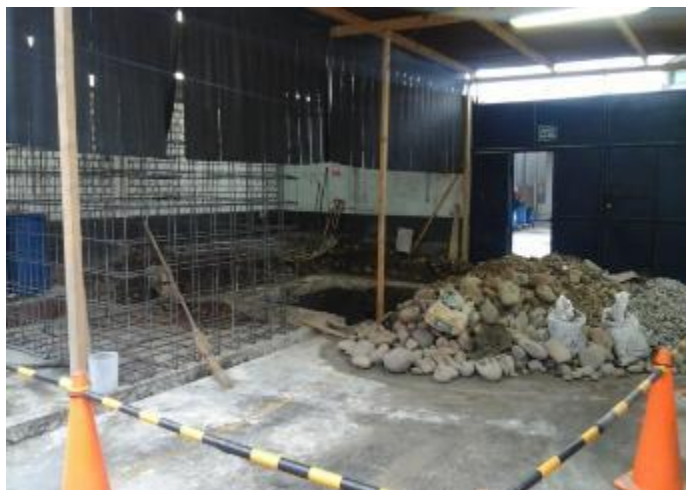
Obras realizadas en la zona 1
