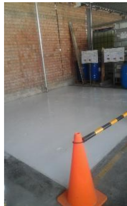
Pintado de piso con pintura epóxica impermeable en todas las zonas
