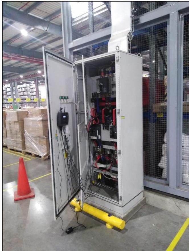
*Figura 11. Analizador conectado y grabando en el tablero de sorter.*
