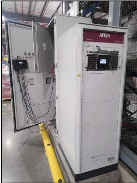
**Figura 18.** *Analizador conectado y grabando en el tablero del sorter, antes y durante la puesta en marcha del filtro activo.*
