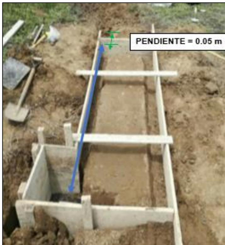
Figura 12: Dimensiones del volumen del humedal artificial
