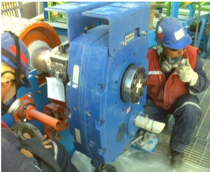
*Fuente propia. Montaje de reductor sobre eje de polea motriz.*
