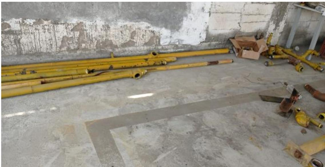
*Figura N° 3. 6. Desmontaje de las Líneas de GLP - Periodo 2021*
