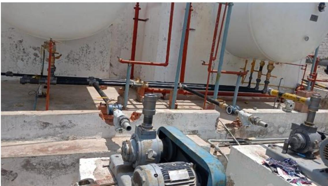
*Figura N° 3. 7. Desmontaje de las Tuberías y Accesorios de la Bomba de GLP - Periodo 2021*
