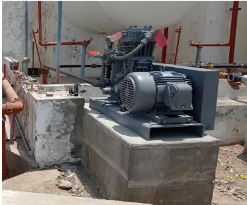
*Figura N° 3. 8. Montaje del Compresor de GLP - Periodo 2022*
