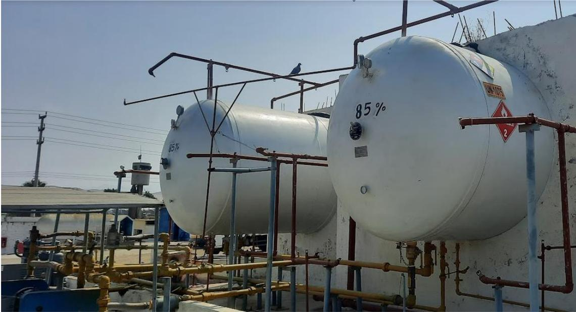
*Figura N° 3. 4. Vista General de las Líneas de GLP entre los Tanques Estacionarios y Bomba de GLP - Periodo 2021.*
