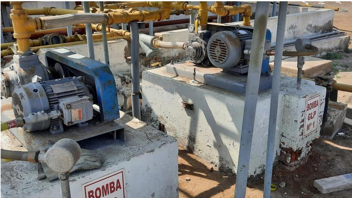
*Figura N° 3. 5. Vista de las Líneas de GLP desde el Ingreso y Salida de la Bomba de GLP - Periodo 2021*
