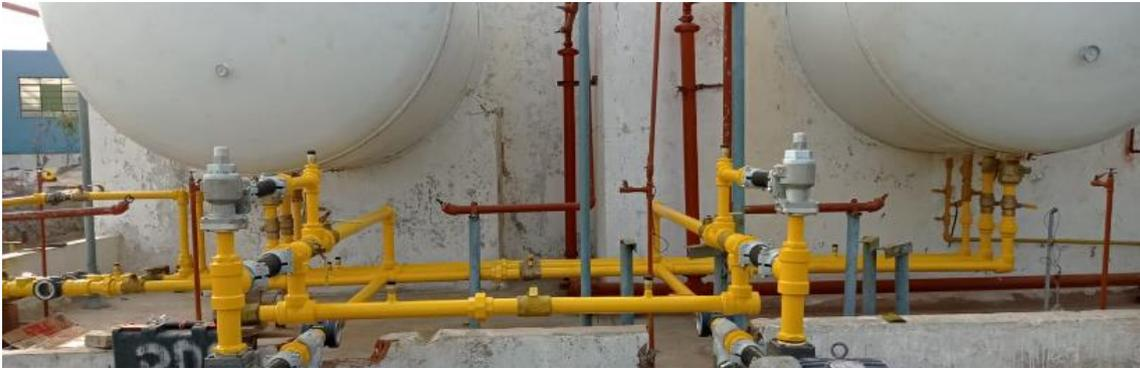
*Figura N° 3. 10. Armado, Prueba de Fugas y Pintado de Nueva Tubería de GLP
