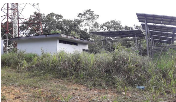
Figura 2.7 – Paneles Solares para Estación Capiri (19)
