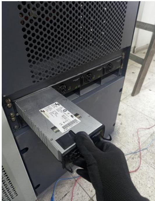
Figura 3.20 – Cambio de rectificador averiado (65)
