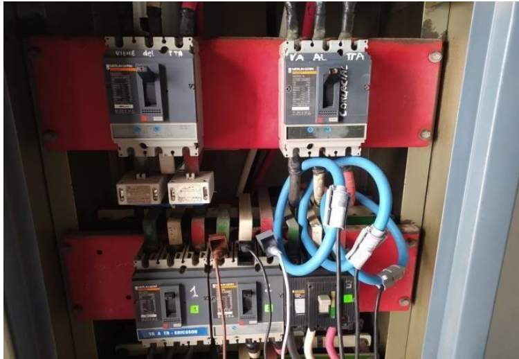
Figura 3.5 – Pinzas de corriente en ITM principal (50)
