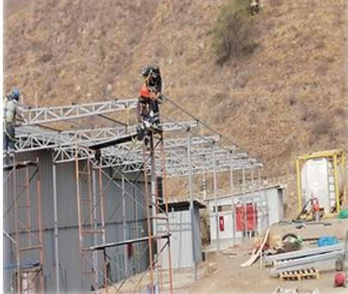
**Figura 7. Fabricación del techo exterior de una planta**
