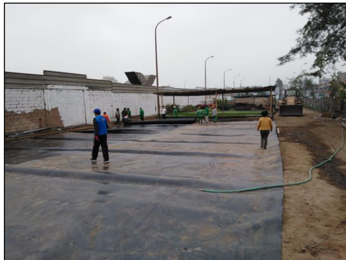
Figura 50. Proceso de construcción de la primera planta piloto de valorización en el 2019 y 2020
