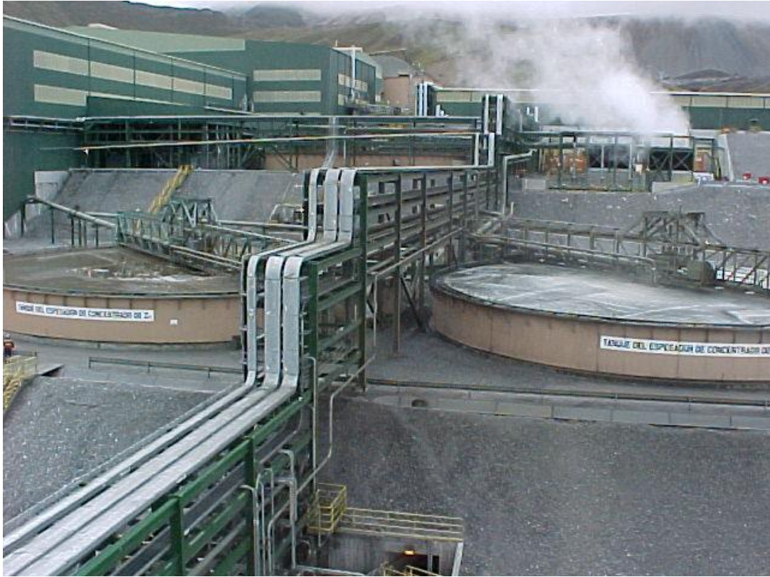
Figura N° 2.29 TANQUES DEL ESPESADOR DE CONCENTRADO DE ZINC Y COBRE.
