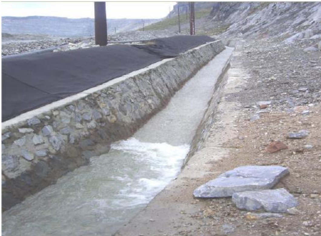
Figura N° 2.45 FINAL DEL CANAL DE AGUAS SUPERFICIALES.
