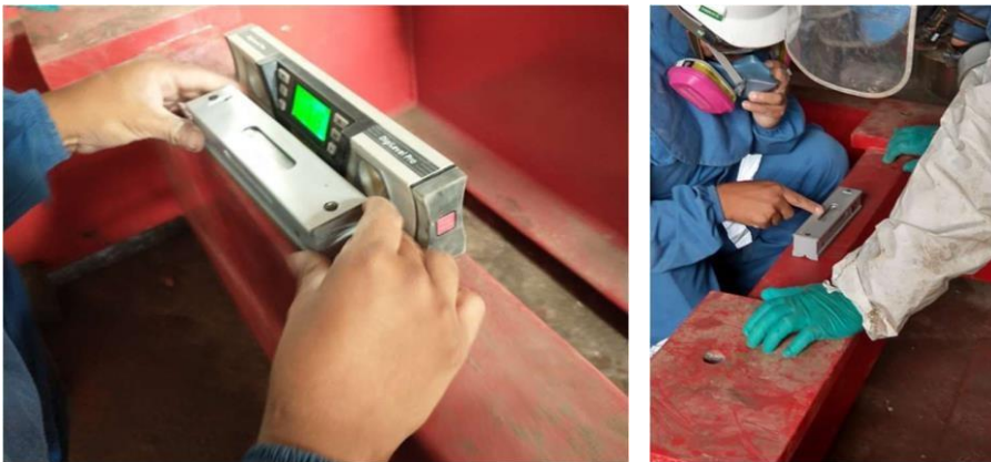
Figura 3.27 Nivelación de bastidor
