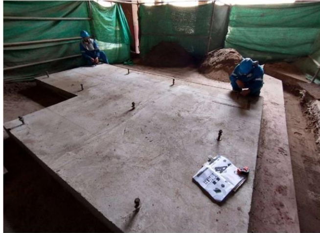
Figura 3.8. Plantillado para pernos de anclaje del bastidor
