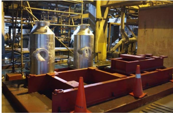
Figura 3.27 Montaje de separadores
