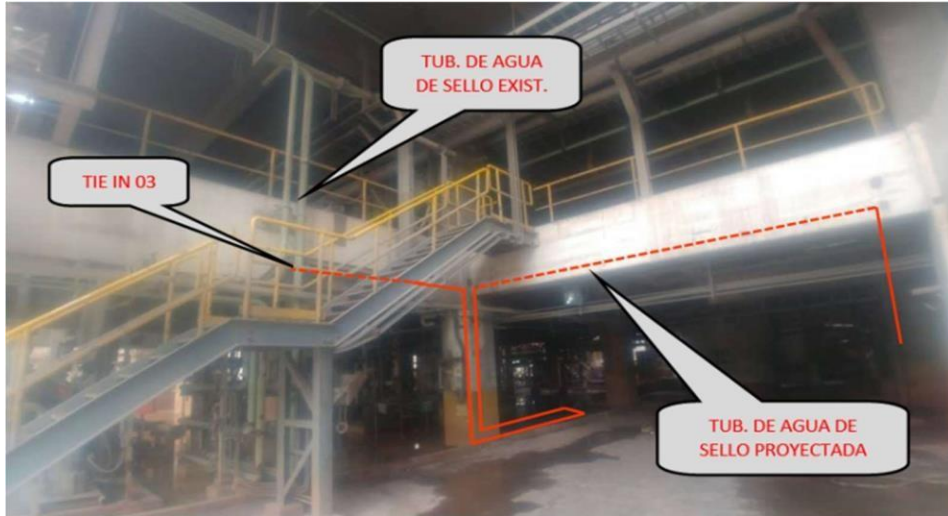
Figura 3.5. Línea de agua de sello proyectado
