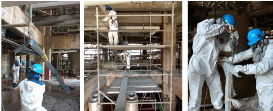
Figura 3.37 Montaje de soportes de la línea de vacío
