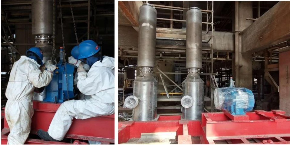
Figura 3.29 Montaje de reductor
