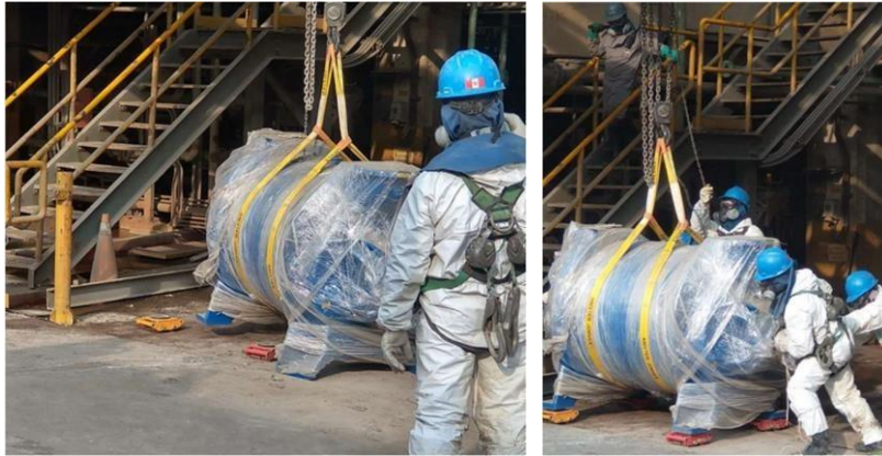
Figura 3.31 Traslado de bomba de vacío
