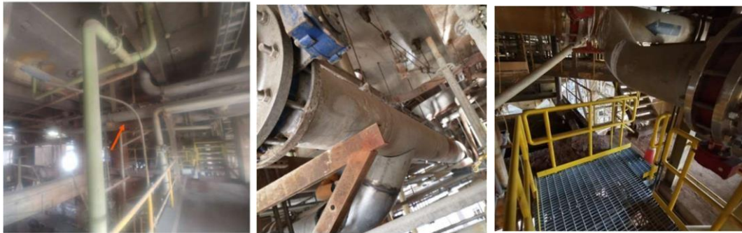
Figura 3.48 Conexión del segundo Tie In.
