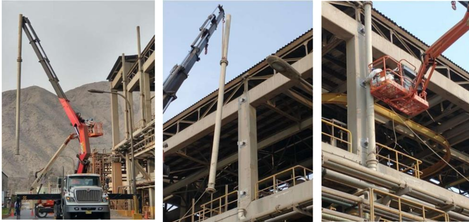
Figura 3.43 Montaje de la chimenea
