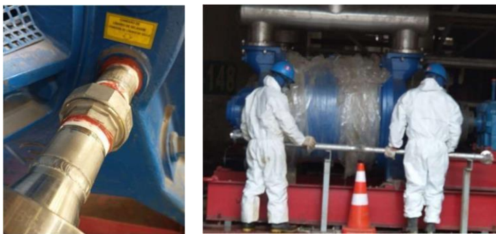
Figura 3.44 Conexión de la línea de agua inoxidable
