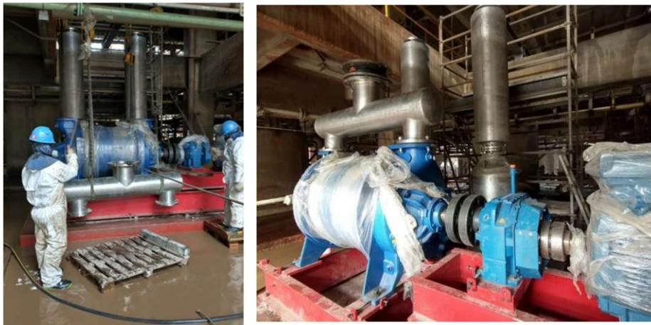
Figura 3.33 Montaje del manifold
