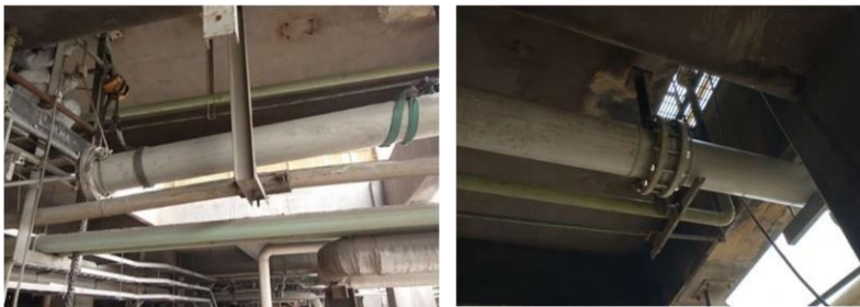
Figura 3.41 Montaje de soportes para la línea de vapor
