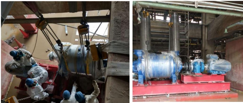
Figura 3.32 Izaje de bomba de vacío
