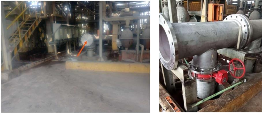
Figura 3.47 Conexión del primer Tie In.
