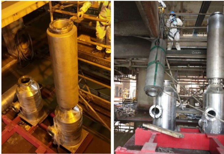
Figura 3.28 Montaje de silenciadores
