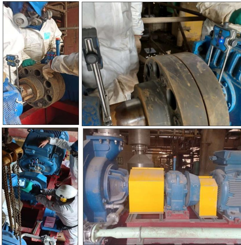
Figura 3.35 alineamiento de bomba y colocación de guarda
