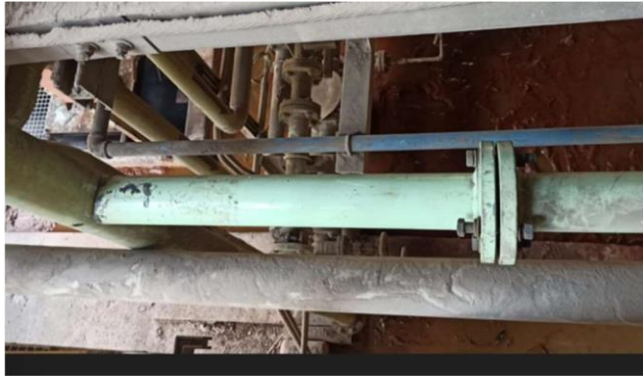
Figura 3.50 Conexión del tercer Tie In
