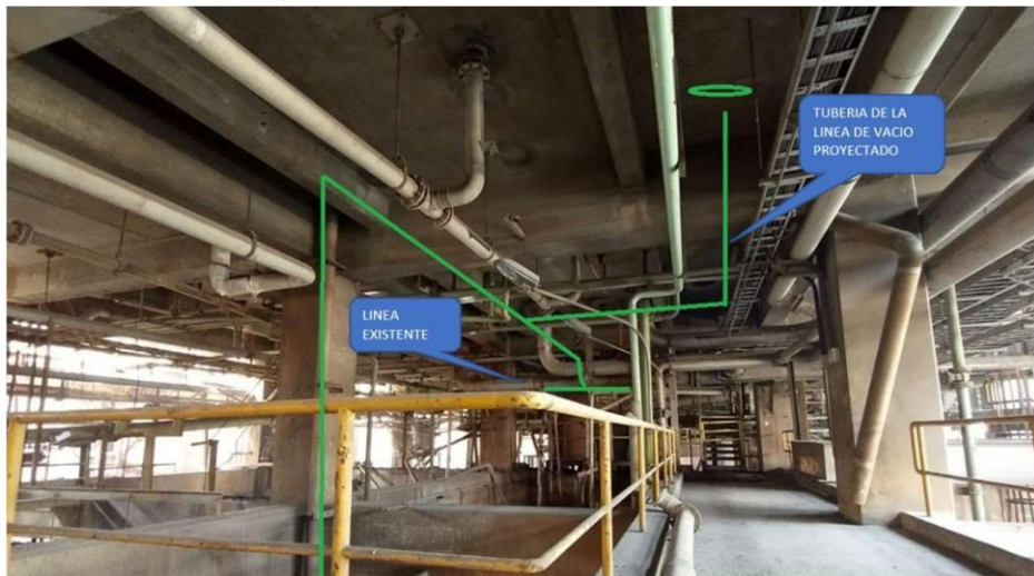
Figura 3.3. Línea de vacío proyectado
