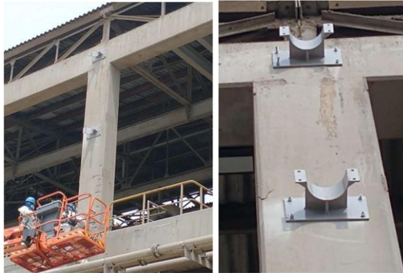
Figura 3.42 Montaje de soportes para la chimenea
