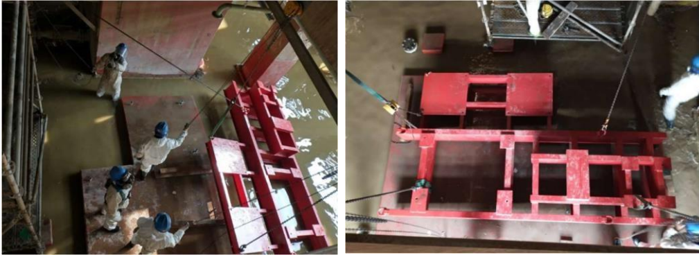
Figura 3.26 Montaje de bastidor
