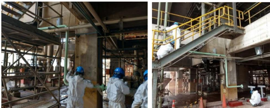
Figura 3.44 Montaje de la línea de agua
