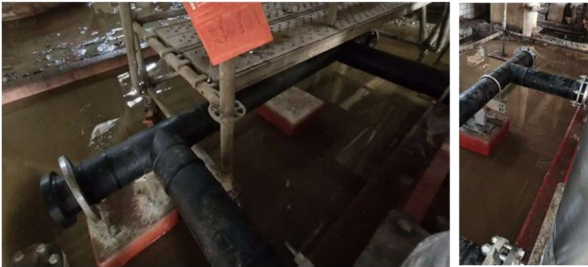
Figura 3.36 Montaje línea de descarga
