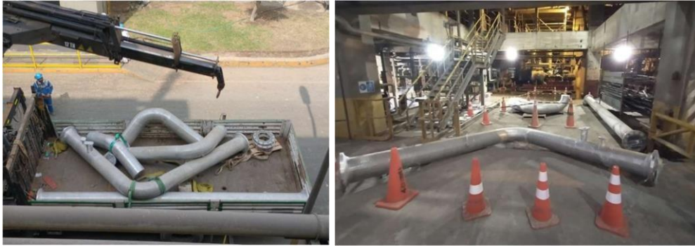
Figura 3.38 traslado de tubería inoxidable
