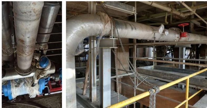
Figura 3.39 Montaje línea de vacío
