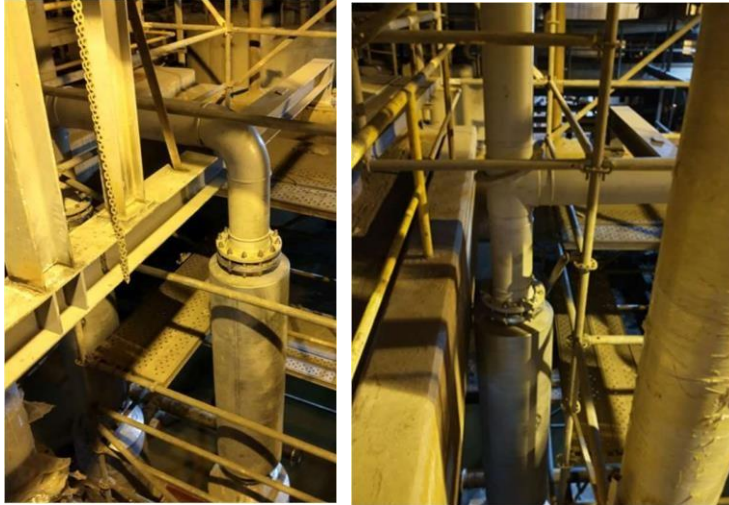
Figura 3.40 Montaje línea de vapor
