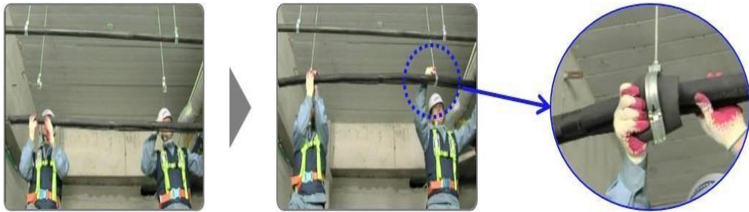
Figura 4.34 ANCLAJE DE SOPORTE PARA TUBERIAS Y MONTAJE
