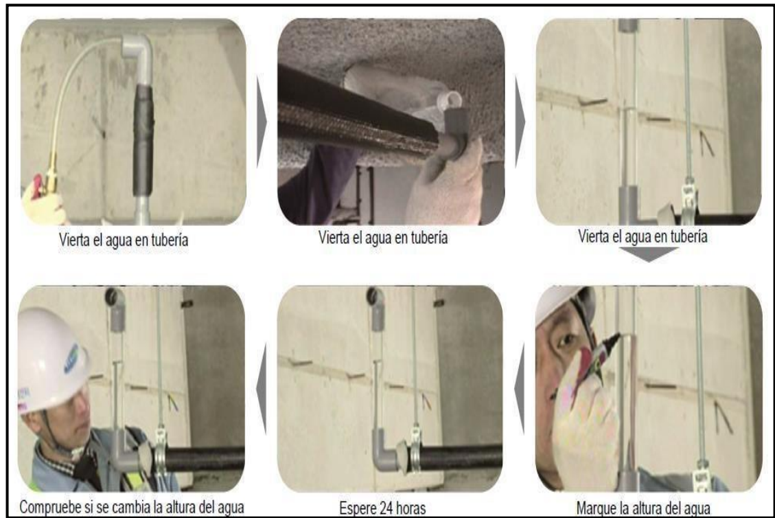
Figura 4.57 PROCEDIMIENTO DE PRUEBA DE DRENAJE
