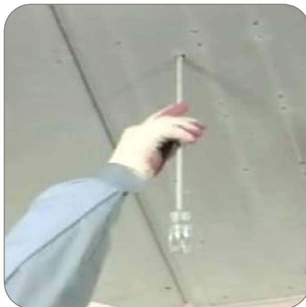
Figura 4.31 ANCLAJE DE SOPORTE PARA TUBERIAS
