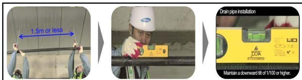
Figura 4.51 PENDIENTE PARA LA TRONCAL DE DRENAJE DE 1/100
