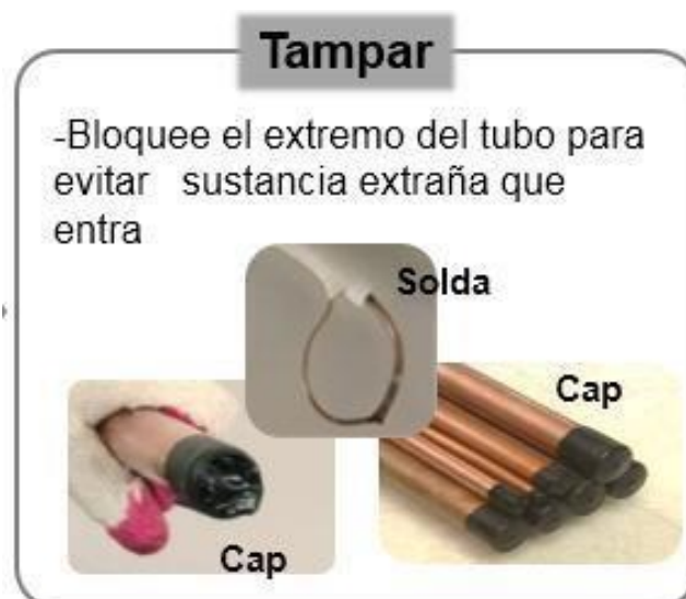
Figura 4.30 TAMPADO DE LA TUBERIA DE COBRE
