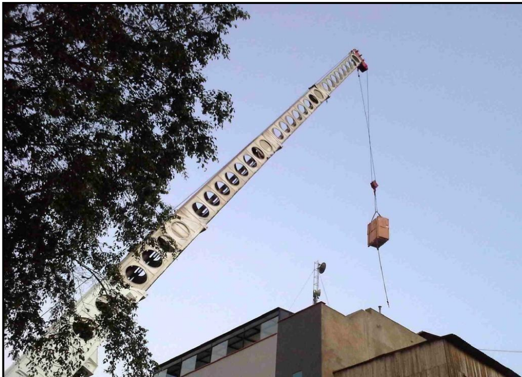
Figura 4.58 MANIOBRA DE IZAJE DE CONDENSADORAS CON GRUA
