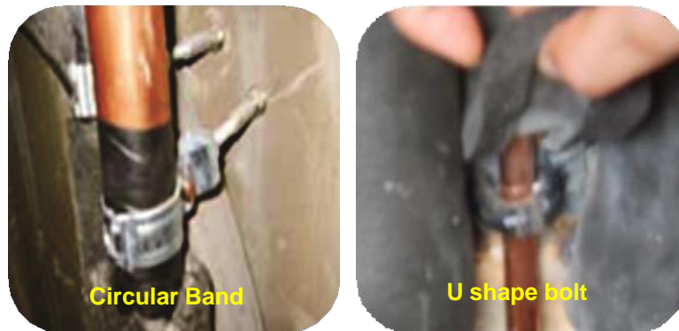
Figura 4.35 ANCLAJE DE SOPORTE VERTICAL
