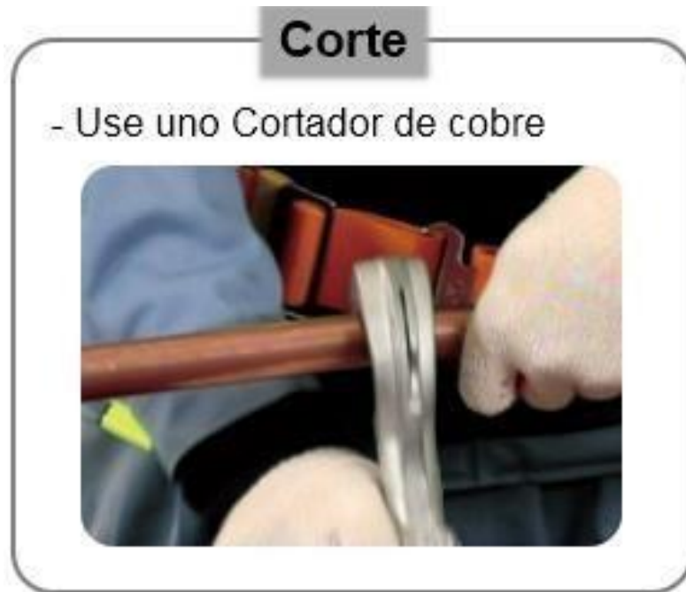
Figura 4.28 PROCESO DE CORTE DE TUBERIA DE COBRE
