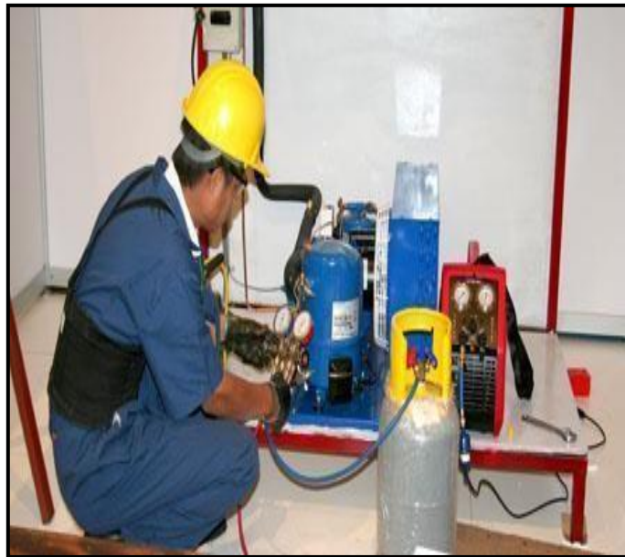
Figura 4.97 PROCESO DE CARGA DE REFRIGERANTE
