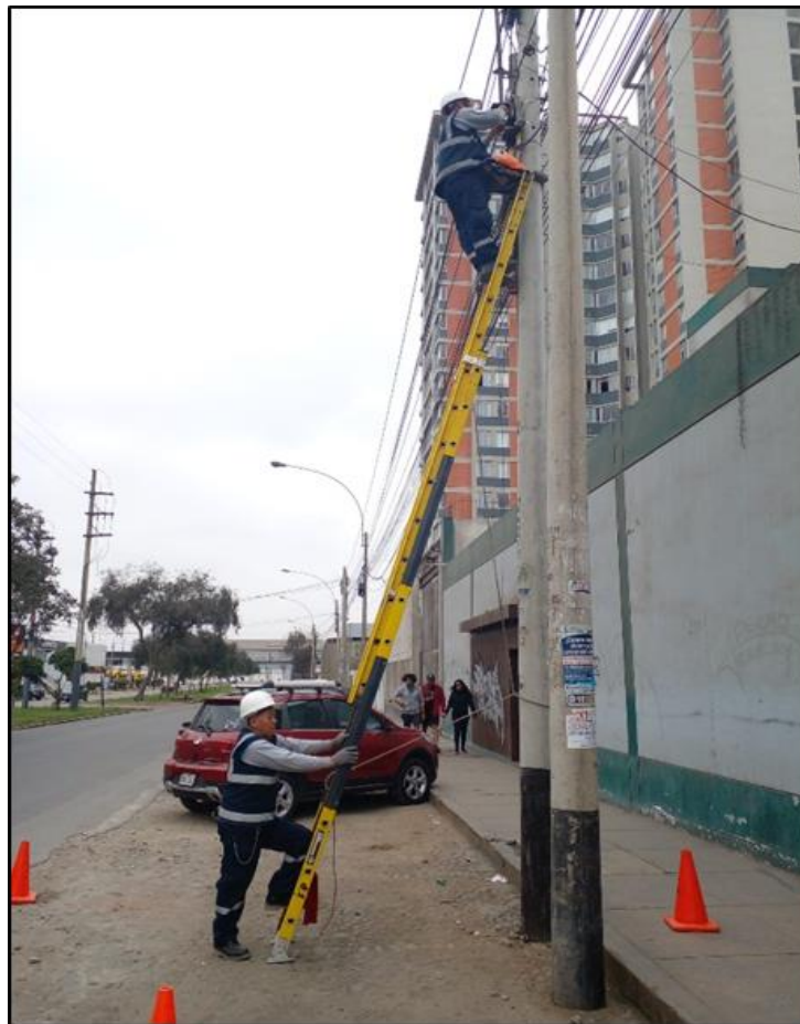
Figura 10. Tendido de fibra óptica elaborado por S.G.P. SAC.
