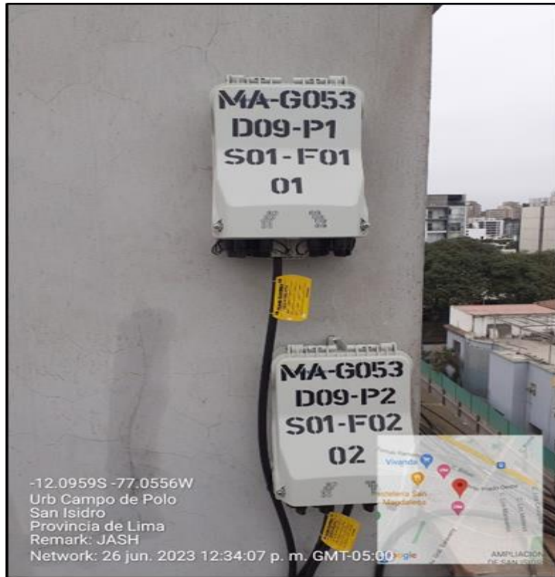
Figura 14. Rotulación de cajas de distribución del tendido por fachada
