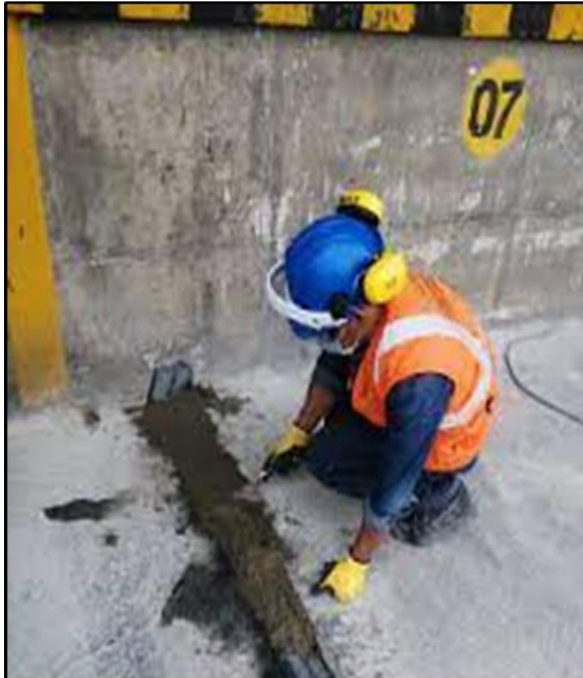
Figura 18. Canalizado para tendido subterráneo
