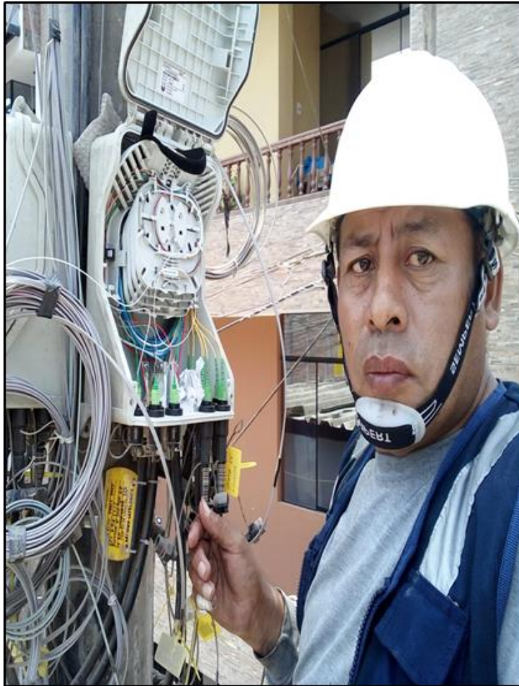
Figura 17. Tendido de fibra Óptica por fachada y empalme óptico de CTO
