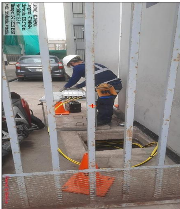
Figura 6. Trabajo de canalización existente
