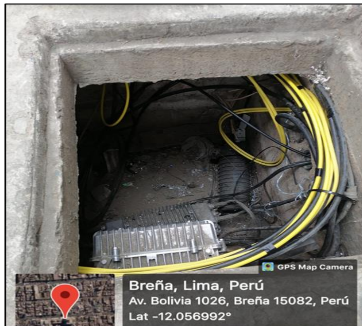
Figura 8. Ingreso al canalizado existente
