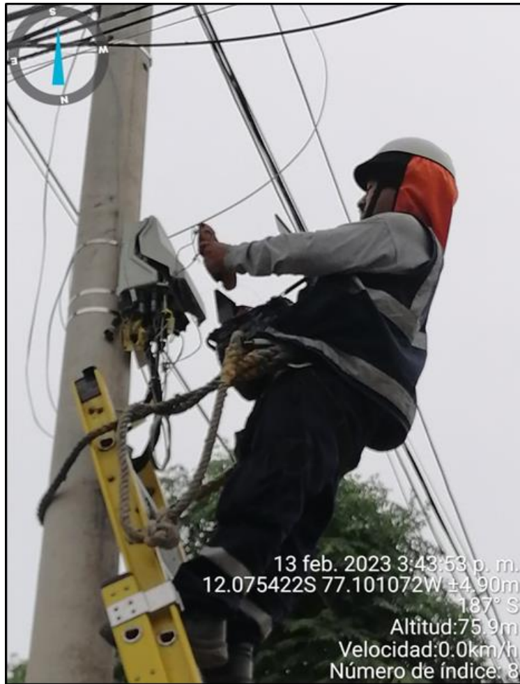
Figura 13. Revisión de Empalme de tendido aéreo
