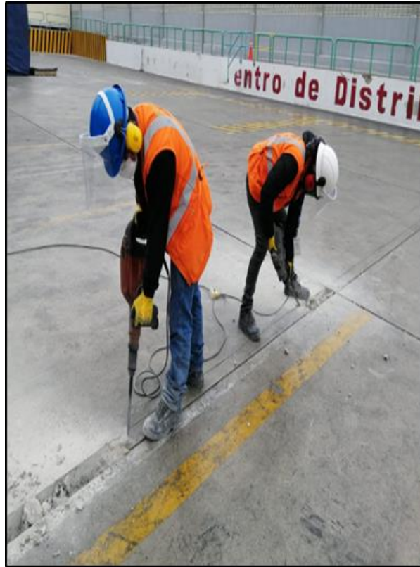
Figura 19. Trabajos de obra Civil para ampliación de cableado subterráneo
