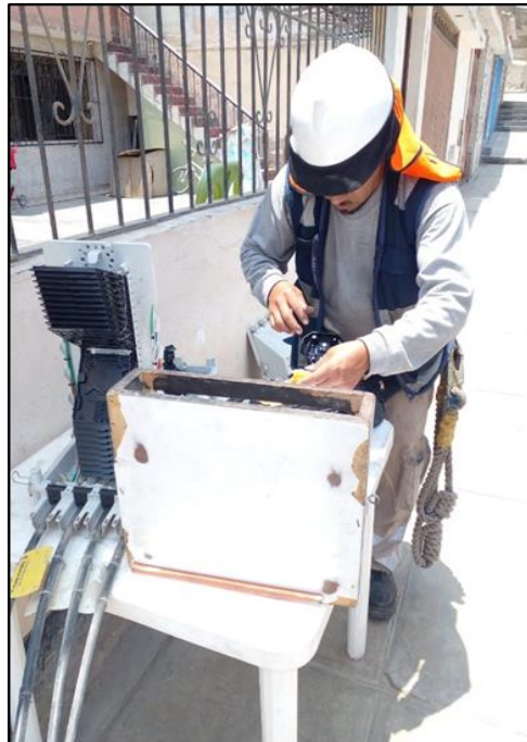
Figura 16. Ordenamiento de mufa para tendido de fibra óptica por fachada
