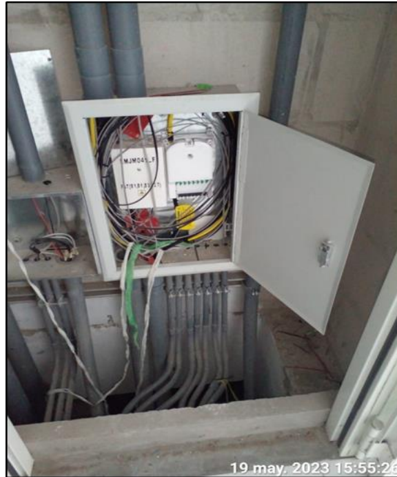
Figura 15. Culminación de tendido de fibra óptica por fachada
