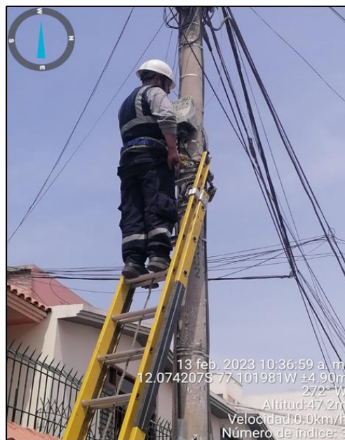
Figura 12. Revisión de caja NAP distribuidora para el tendido aéreo
