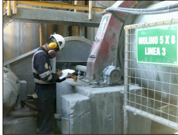
Figura 3.12 Toma de medición, vibración y temperatura en M5X8 L3
