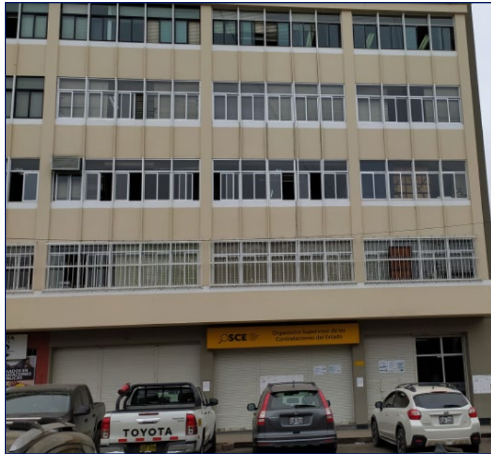
Figura 1. Edificio de actividades administrativas del sector público
