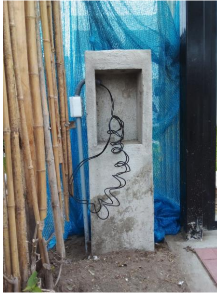
Fig.52 Estructura de cemento que cuenta con una cajuela
