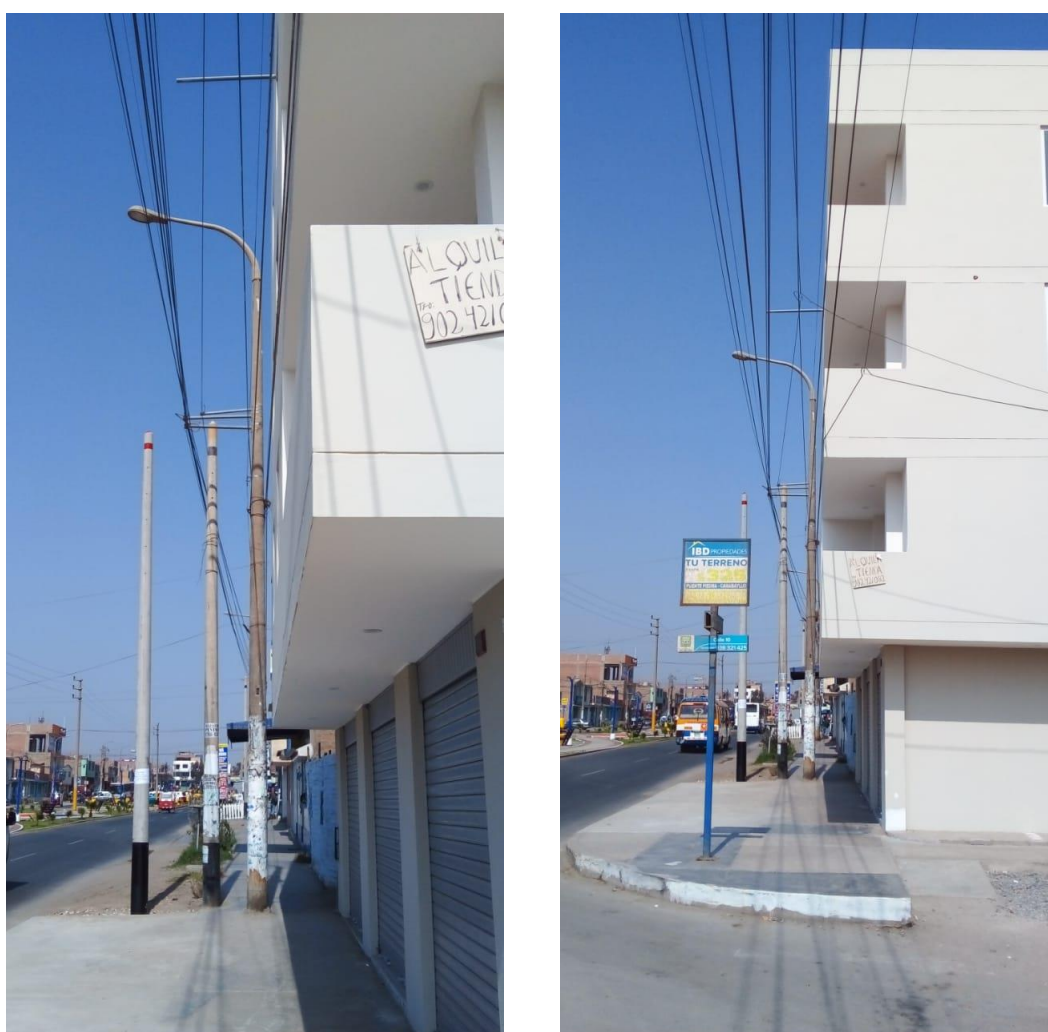
Fig.49 Ejemplos de violaciones a las reglas del CNE Suministro – Distrito de Santa Rosa, Lima - Perú
