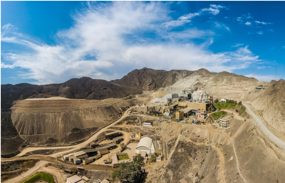
Figura 3-2: Planta concentradora y oficinas de unidad minera condestable.
