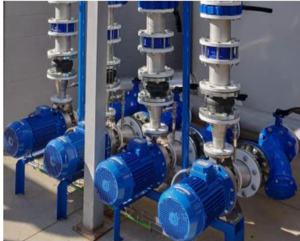
Figura 2-14 Bomba centrífuga horizontal
