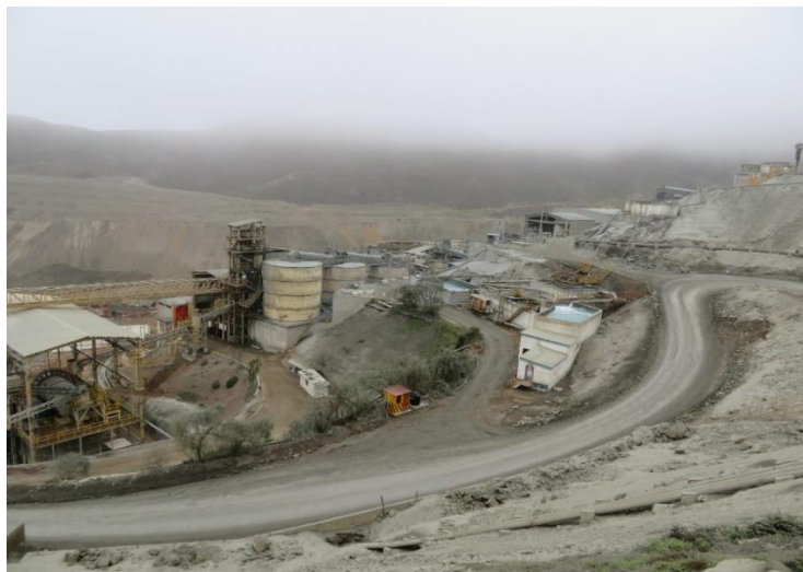
Figura 2-2 Planta concentradora CMC, tolva de finos.
