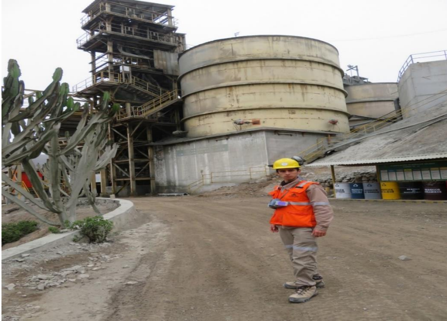
Figura 2-3 Planta Concentradora – Tolva de finos N°07
