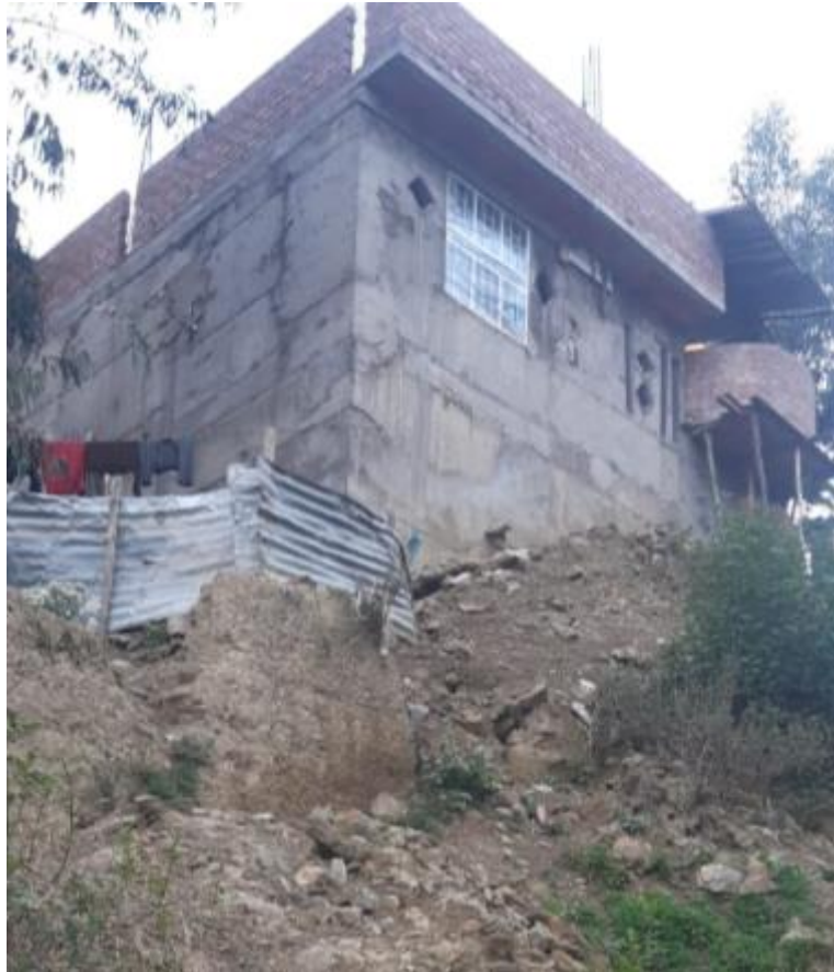
Vista de una vivienda construida en las faldas del cerro.
