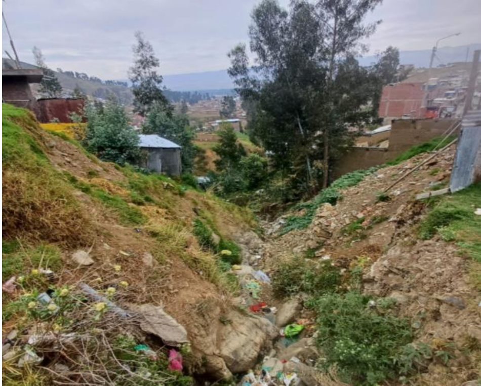
Vista del barranco con viviendas habitadas
