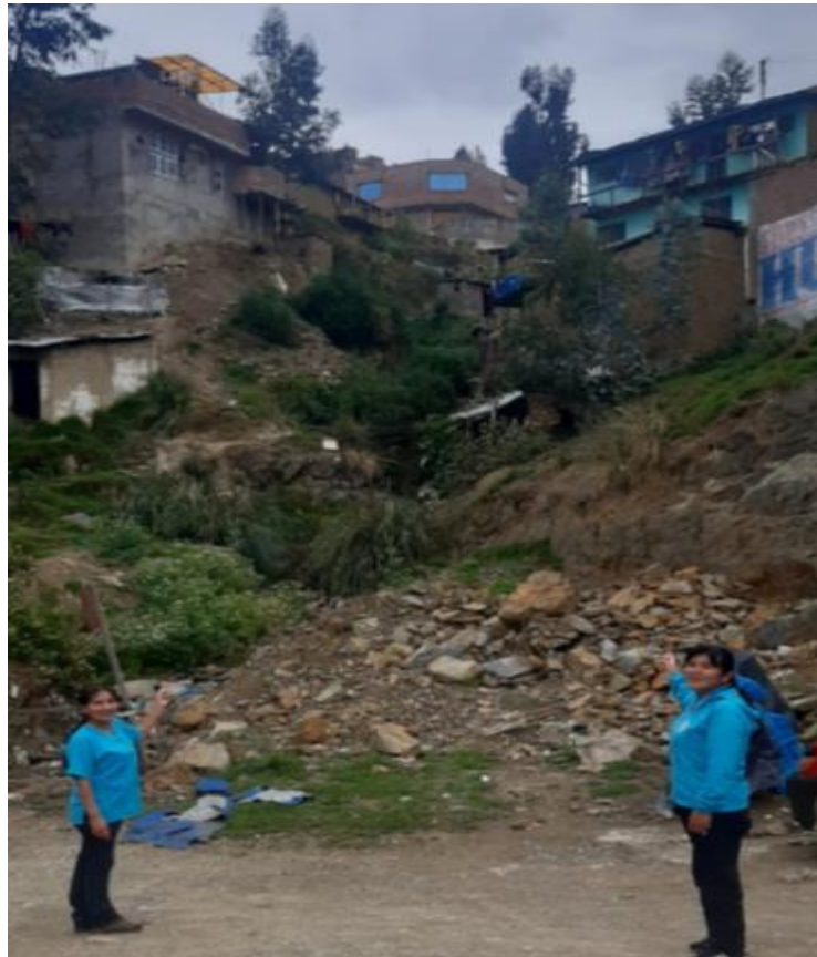
Vista de la peligrosidad de las viviendas
