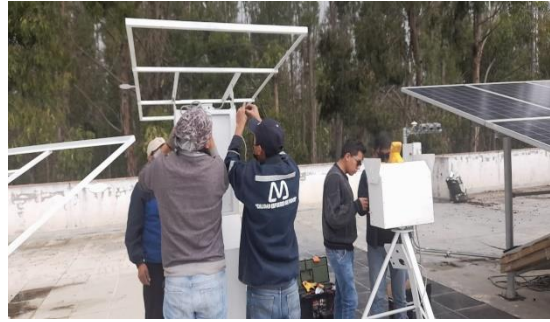
INSTALACIÓN DE ESTRUCTURAS DE SOPORTE
