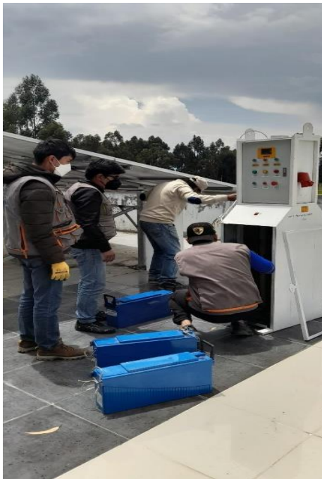
INSTALACIÓN DE BANCO DE BATERÍAS
