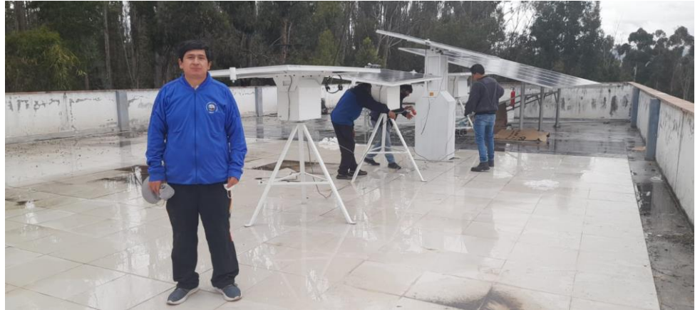
Figura 59. Verificación final de la instalación
