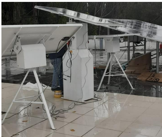
Figura 56. Instalación de los seguidores solares en a UNCP
