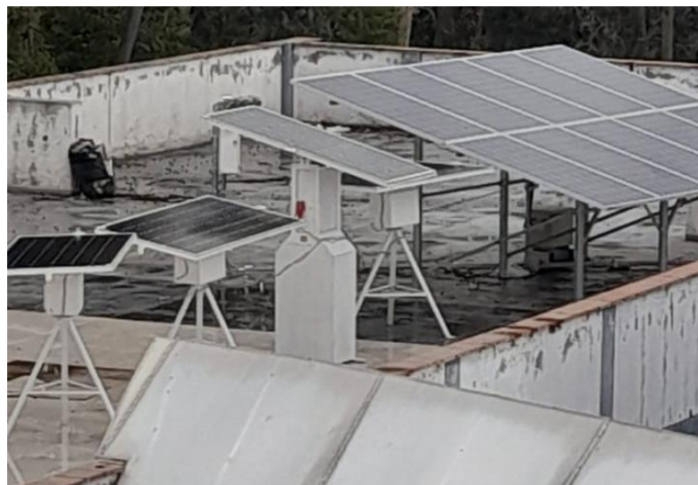
Figura 60. Resultado final de la instalación
