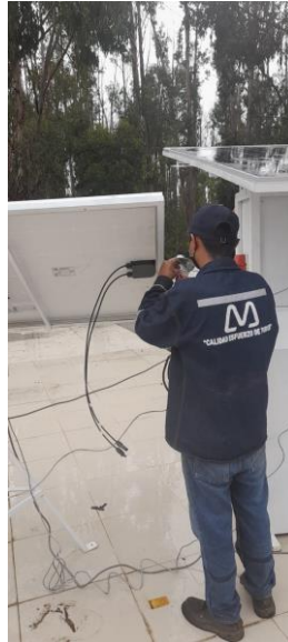
Figura 57. Instalación de periféricos
