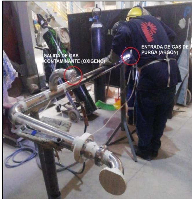
En el Anexo 08 se muestra el documento POLINDUSTRIA/PUCP WPS 001, la cual fue una de las Especificaciones de procedimiento de soldadura (WPS) y que aplicó a la soldadura de junta a tope de tuberías inoxidables grado sanitario. Se revisó la totalidad de WPS en relación a la disciplina de Mecánica y Piping sin encontrar observaciones.
