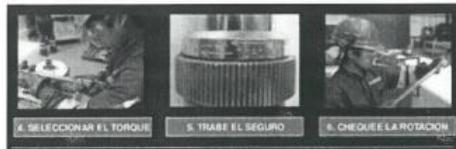
El Torque de los pernos de Conexión de estructuras metálicas se realizará en obra siguiendo la presente tabla donde establece un rango de valores en Libras-Pie.
