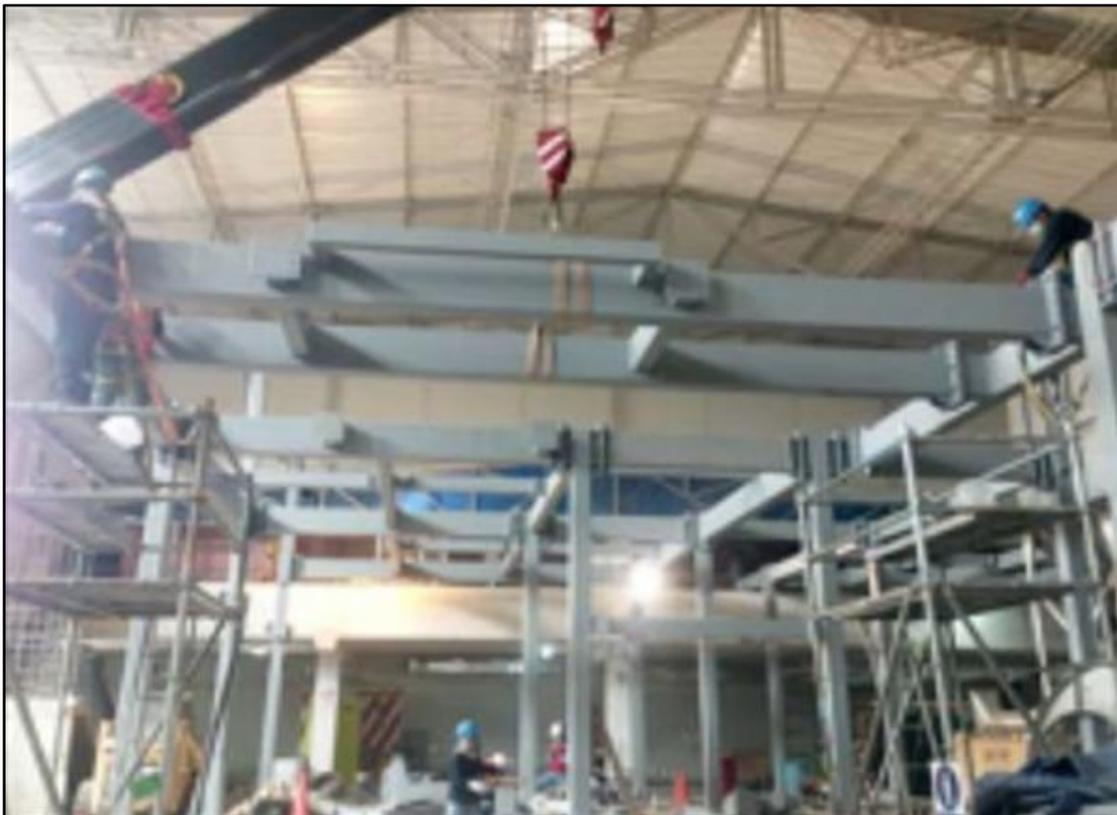
Figura 3.19: Montaje de estructuras pre ensambladas - Navisworks
