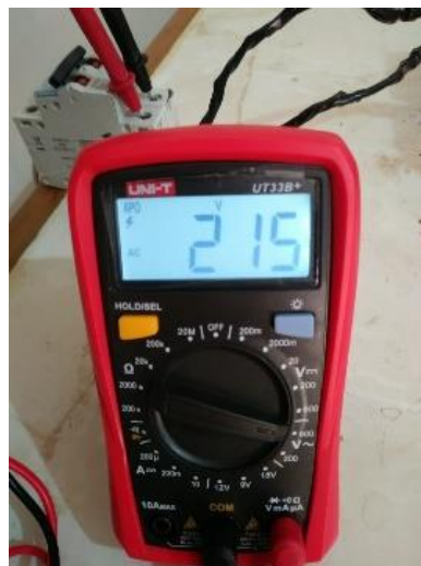
Figura 5.1. Medición de voltaje de operación
