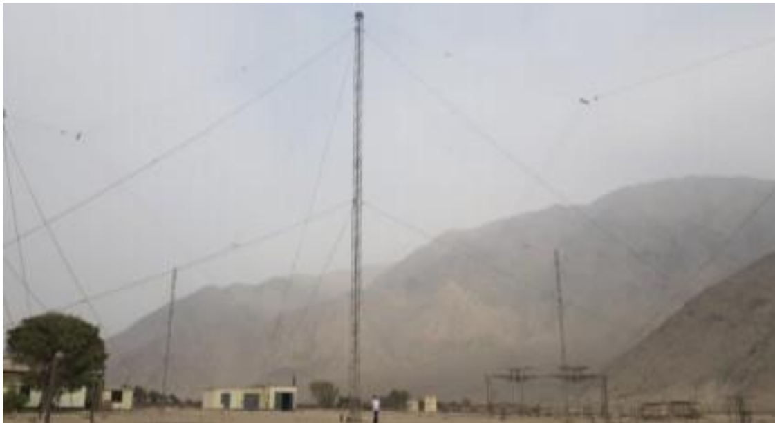
Fig. 2. Antena transmisora delta cruzada simple del sistema DPS-4 [16].
