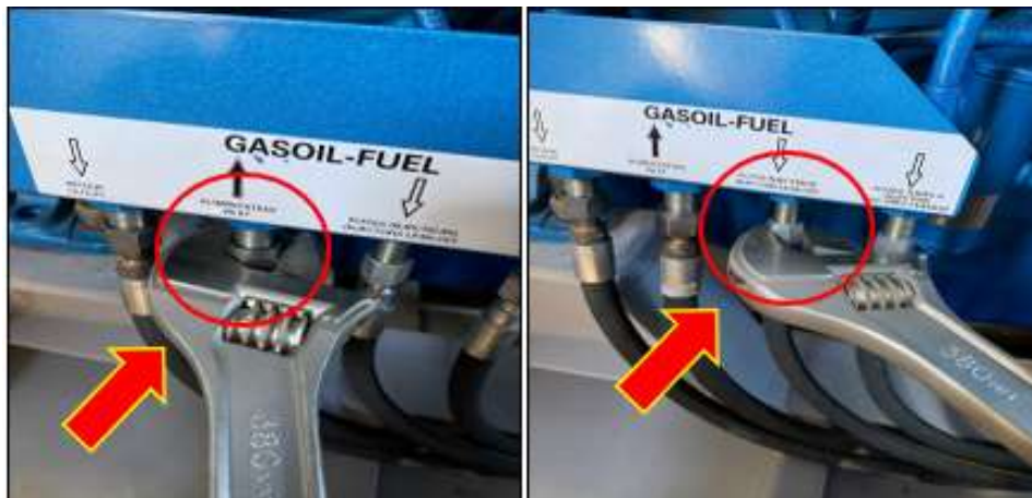
Figura 3.13. Ajuste de las conexiones de las mangueras de combustible
