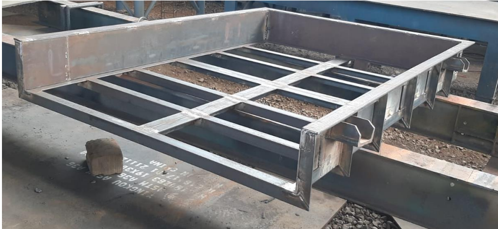
Figura 4.17 Armado de elementos estructurales
