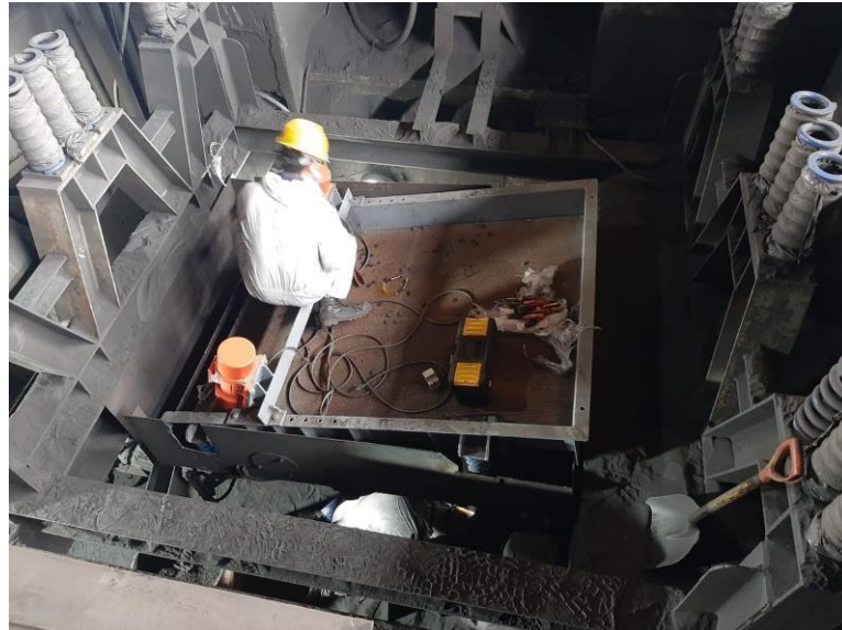
Figura 4.21 inicio de ensamblaje de zaranda en planta
