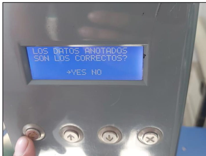
Figura N° 66. Confirmación final de parámetros de funcionamiento Fuente: Elaboración propia
