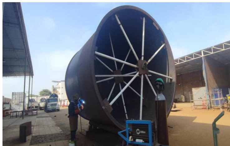
Figura 4.7 Soldeo de casco de tanque
