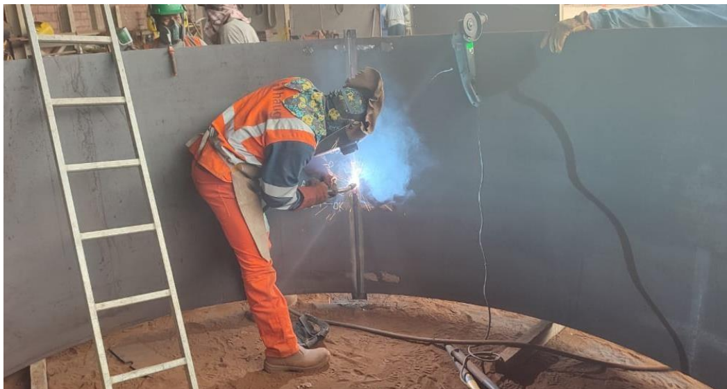
Figura 2.10 Soldeo por proceso de GMAW
