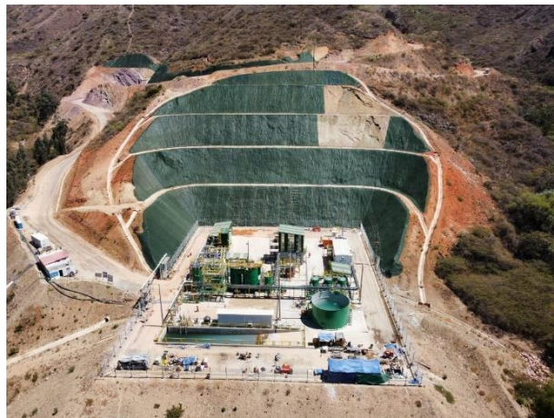
Figura 4.1 Planta de tratamiento de aguas ácidas Unidad Minera Shahuindo
