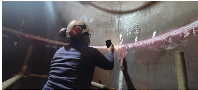
Figura 4.10 Inspección de juntas horizontales
