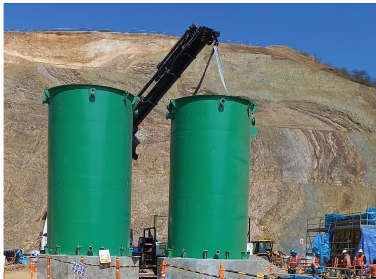
Figura 4.29 Montaje de tanques de neutralización y oxidación
