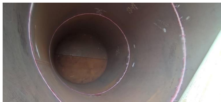
Figura 4.11 Inspección de juntas horizontales
