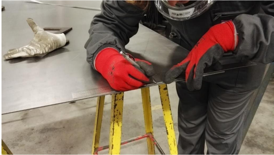
Figura 2.6 Trazado de planchas de acero
