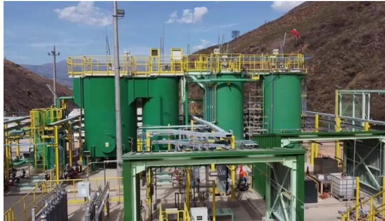
Figura 4.30 Montaje de tren de tratamiento principal
