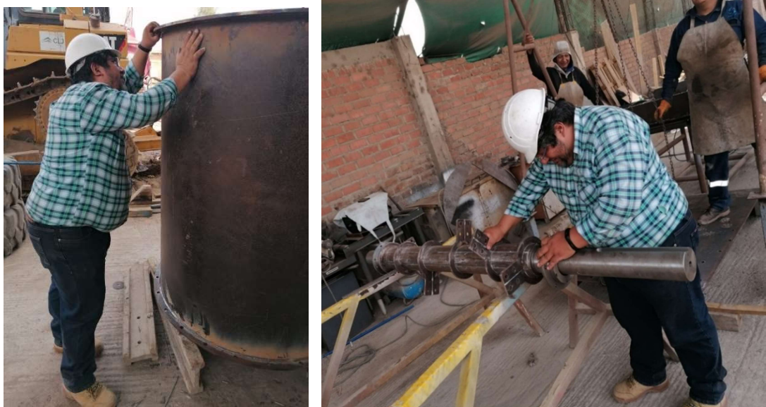
Figura N° 3.6 – Inspeccionando el soldado de la brida del Mezclador.
