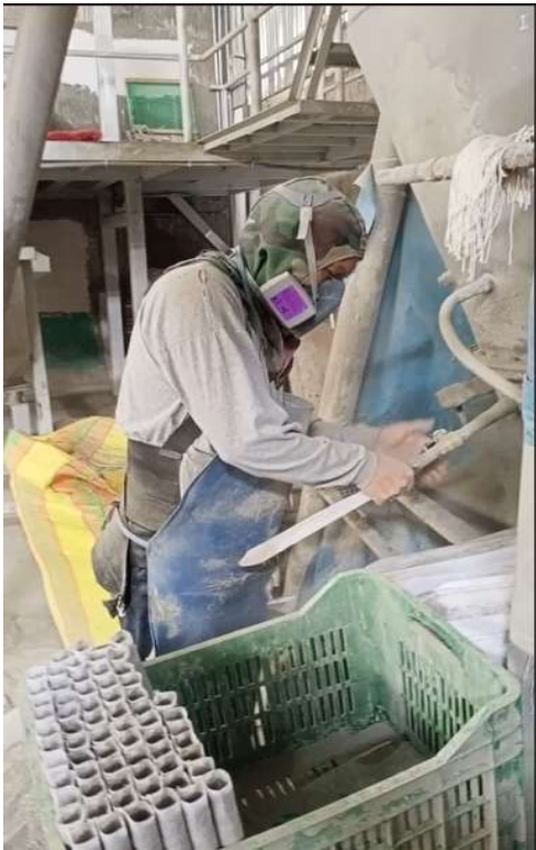
Figura N° 2.17 – Operario llenando del silo de cemento - Cartuchos para rellenar los agujeros de los Split Set
