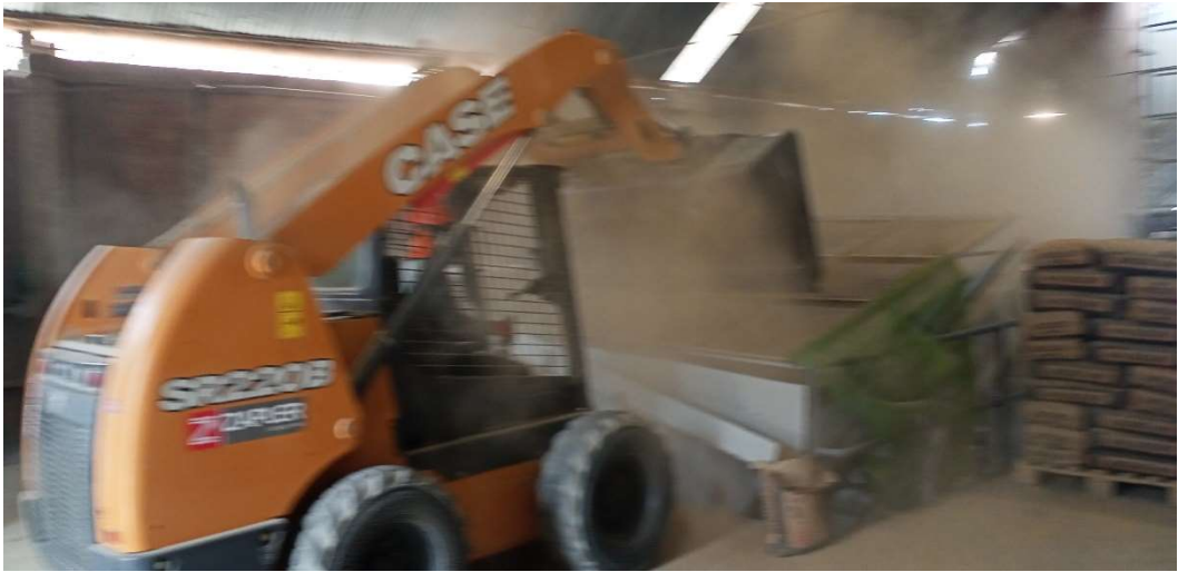
Figura N° 2.14 – Fotos antigua planta de FORTECEM – Foto 1- Llenando la tolva de áridos
