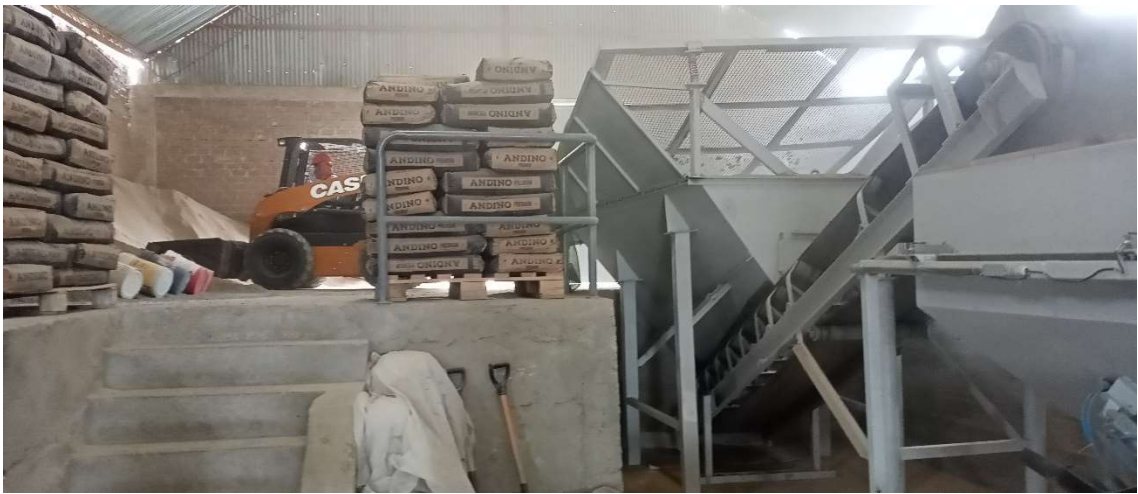
Figura N° 2.15 – Tolva de áridos y faja transportadora hacia mezcladora de tambor
