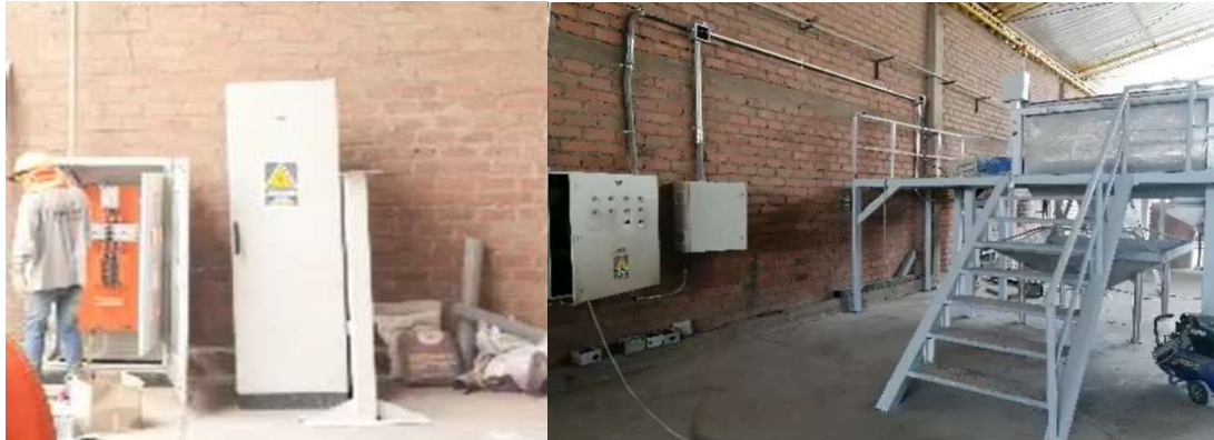
Figura N° 2.31. – Montaje de Instrumentación Eléctrica y Neumáticas Gral.
