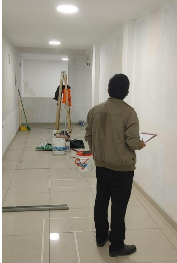
Figura 9: Trabajos de Remodelación
