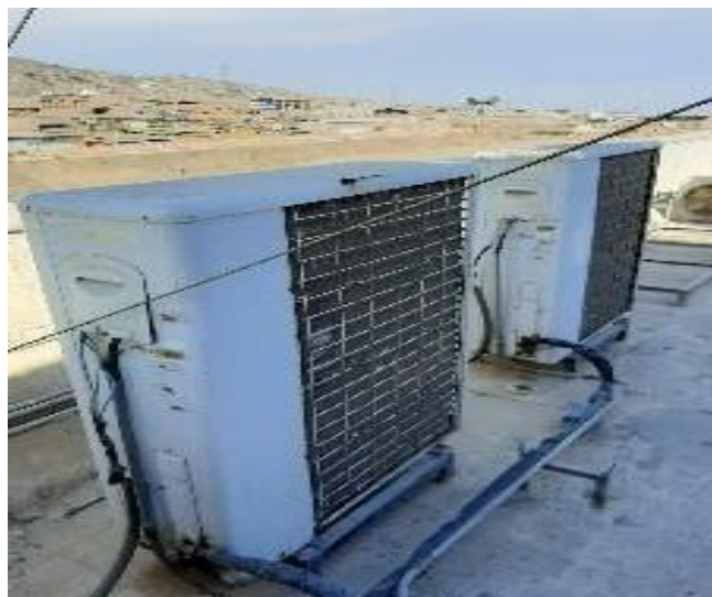
Figura 3.7 Compresor de aire del 4to piso
