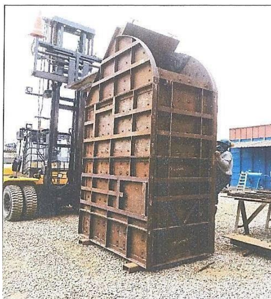
Imagen 3.8 Preensamblado del chute 22
