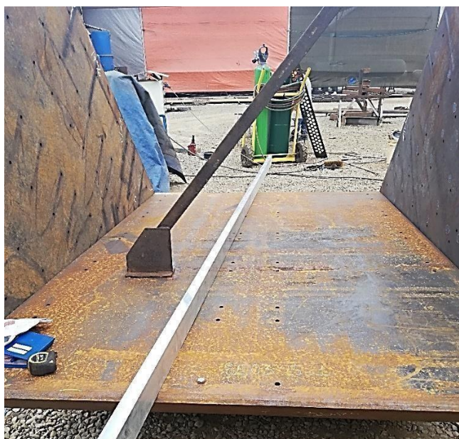
Imagen 3.5 Verificación de la planicidad de una pieza del subensamble EG.02.SD.25.A_B del chute 25
