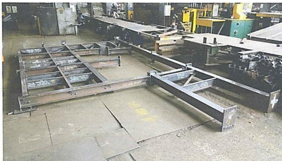
Imagen 2.2 Plataforma de mantenimiento e inspección
