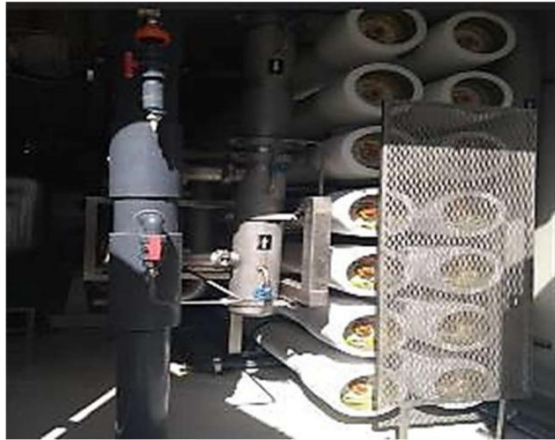
Figura 3.14. Montaje de Equipos de Osmosis de Inversa RO (17)
