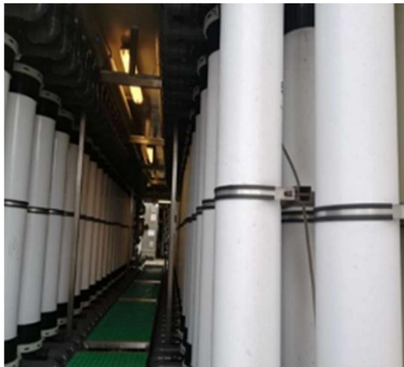
Figura 3.12. Montaje de Equipos de Ultrafiltración UF (17)
