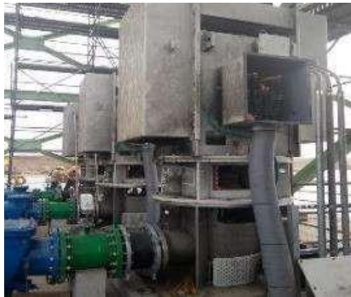
Figura 3.5. Montaje y ensamble de bomba verticales zona Captación (17)
