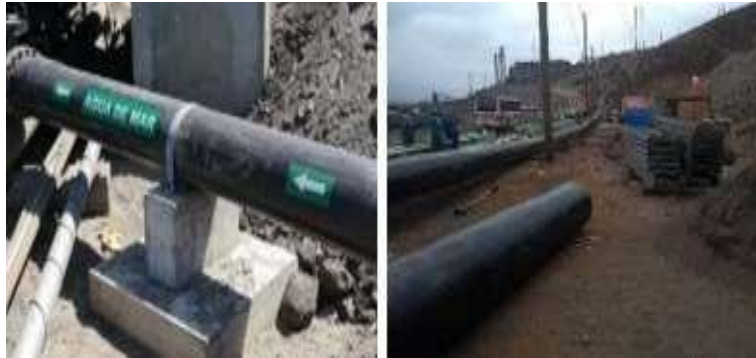
Figura 3.27. Montaje de línea de tubería PE Captación (17)
