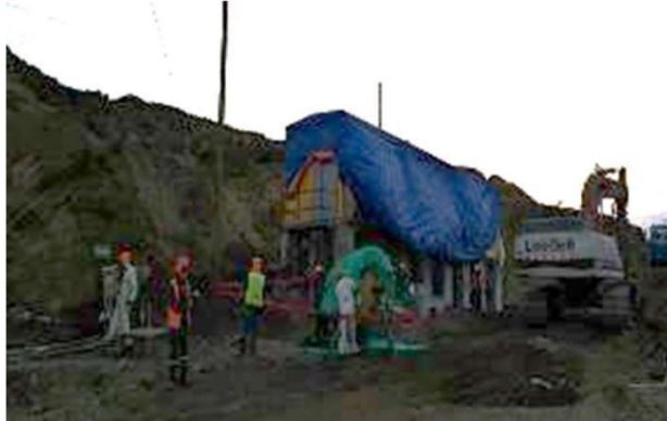
Figura 3.4. Montaje de Sala eléctrica EHOUSE 1910-ER-100 (17)
