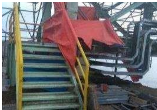
Figura 3.20. Tendido de bandeja y cable en zona de captación (17)
