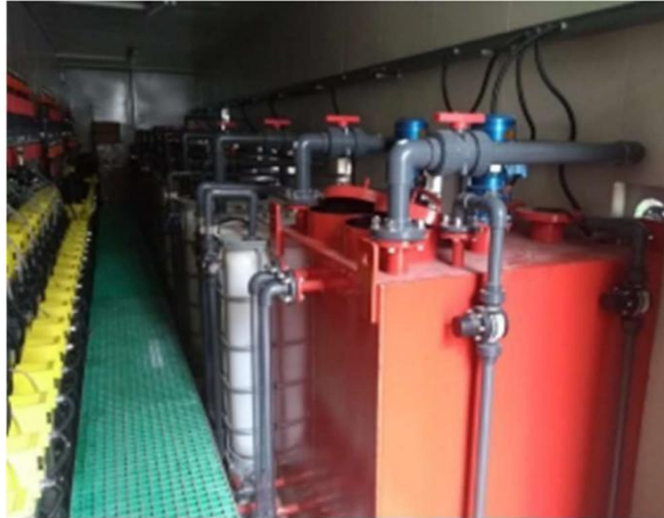
Figura 3.16. Montaje de Equipos de dosificación (17)
