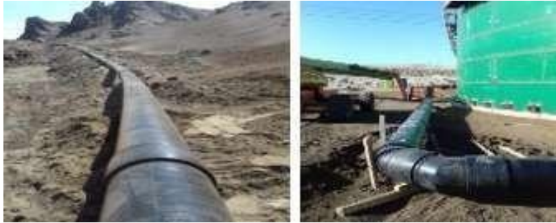
Figura 3.33. Montaje de Línea de tubería PE, agua producida (17)
