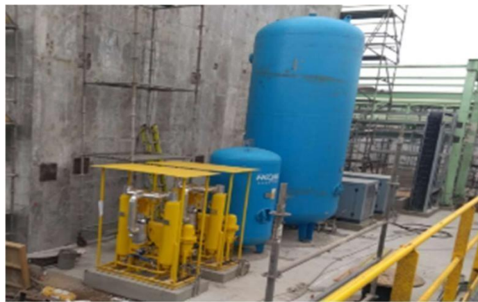
Figura 3.15. Montaje de Equipos de Aire de Proceso e Instrumentación (17)
