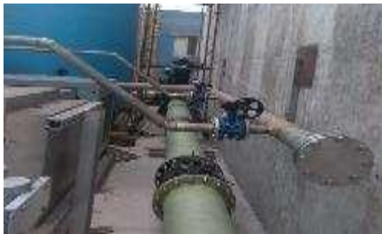
Figura 3.29. Montaje de Línea tuberías de inox 316L de Aire (17)
