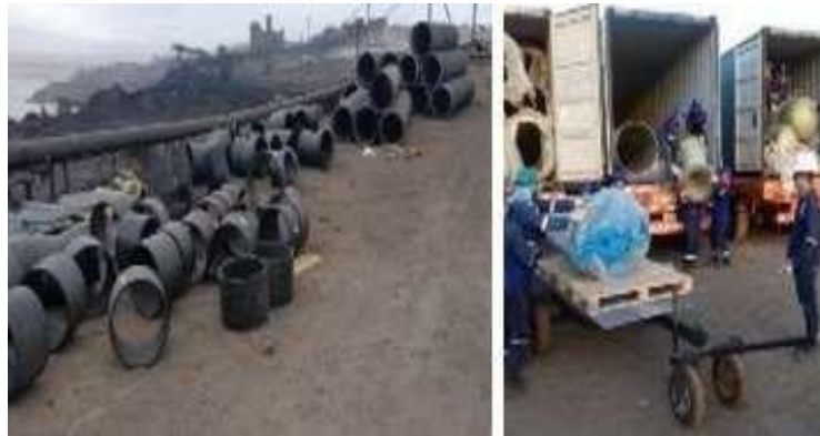
Figura 3.25. Recepción de tuberías PFRV, PE e inox. Acero reforzado (17)
