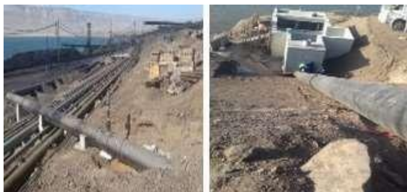
Figura 3.32. Montaje de Línea de tubería PE, agua de rechazo salmuera (17)
