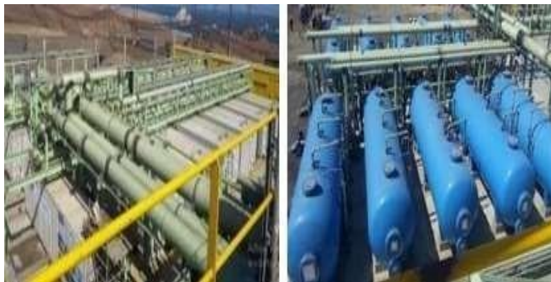
Figura 3.28. Montaje de estructura y líneas de tuberías de PFRV de ingreso y salida de los equipos de la planta desalinizadora (17)
