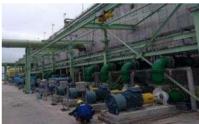
Figura 3.31. Montaje de Línea de tuberías de Acero revestido interiormente con PE, Succión y Descarga de bombas (17)
