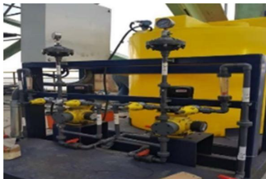
Figura 3.6. Montaje de equipo dosificador en zona captación (17)
