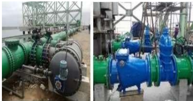
Figura 3.26. Montaje de tubería de acero con revestimiento de PE interior (17)
