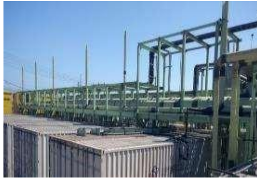
Figura 3.19. Tendido de bandeja y cable en planta de tratamiento (17)
