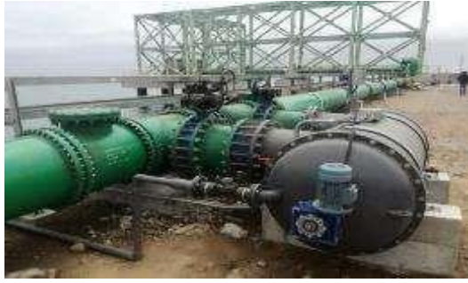
Figura 3.7. Montaje de equipo Filtro autolimpiante en zona captación (17)
