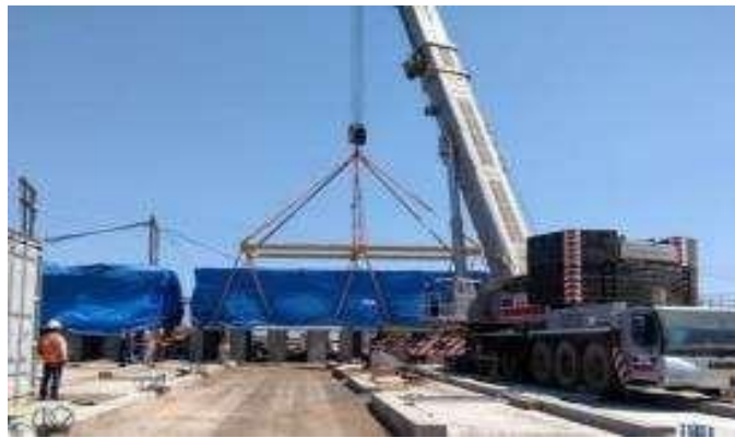
Figura 3.8. Montaje de Sala Eléctrica E- HOUSE 1920-ER-100/100A./100B (17)
