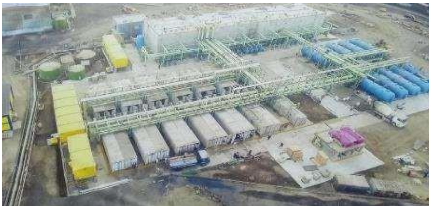
Figura 3.38. Vista aérea - Construcción de la nueva Planta desaladora (17)
