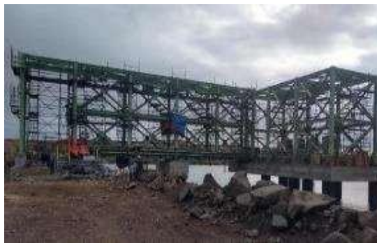
Figura 3.1. Inspección de Obras civil y de estructura en zona Captación (17)
