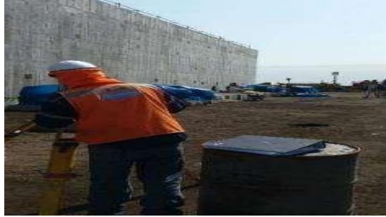
Figura 3.2. Verificación de punto de niveles en la planta desaladora (17)
