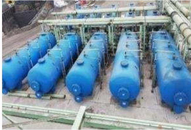
Figura 3.10. Montaje de filtro Multimedia de arena SF (17)
