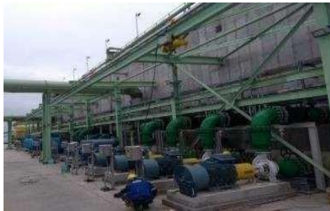
Figura 3.9. Montaje de Bombas de la Planta de Desaladora (17)
