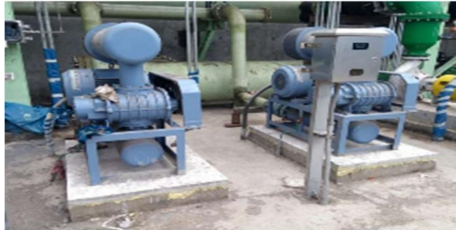
Figura 3.11. Montaje de equipos Soplador de aire SF (17)
