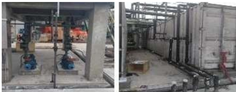
Figura 3.30. Montaje de línea tuberías de PVC y PE de agentes (17)
