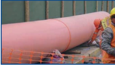
Obra Primavera, línea de alcantarillado tubos 900 mm.
