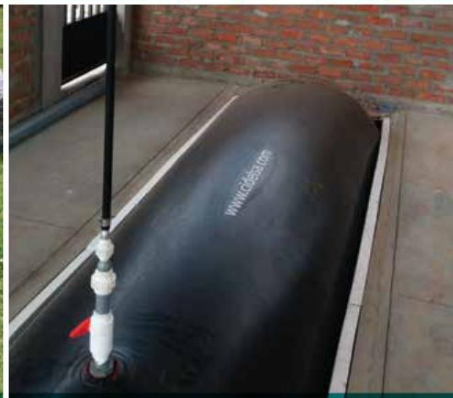
Biodigestor tubular, Proyecto UDEP - Piura.
