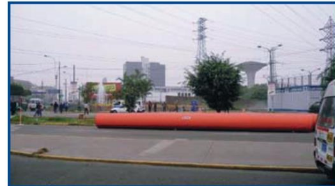
Obra Sedapal, conducción de agua potable (únicos en el Perú en fabricación de tubos 1200 mm).
