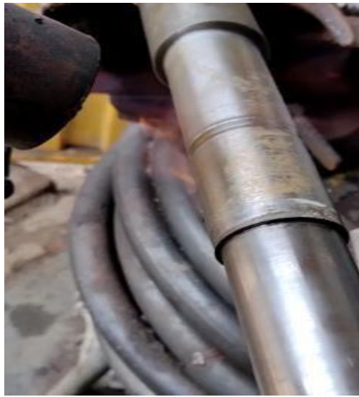
Figura N°20 Pre calentamiento de la Pieza
