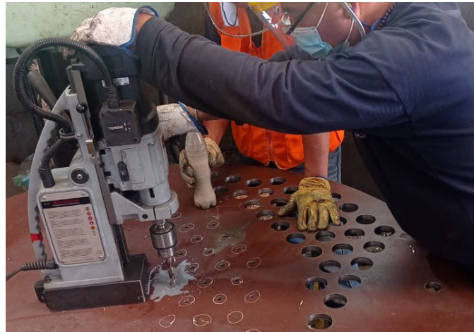
Figura 4.16. perforación de plancha de caldera usando machina
