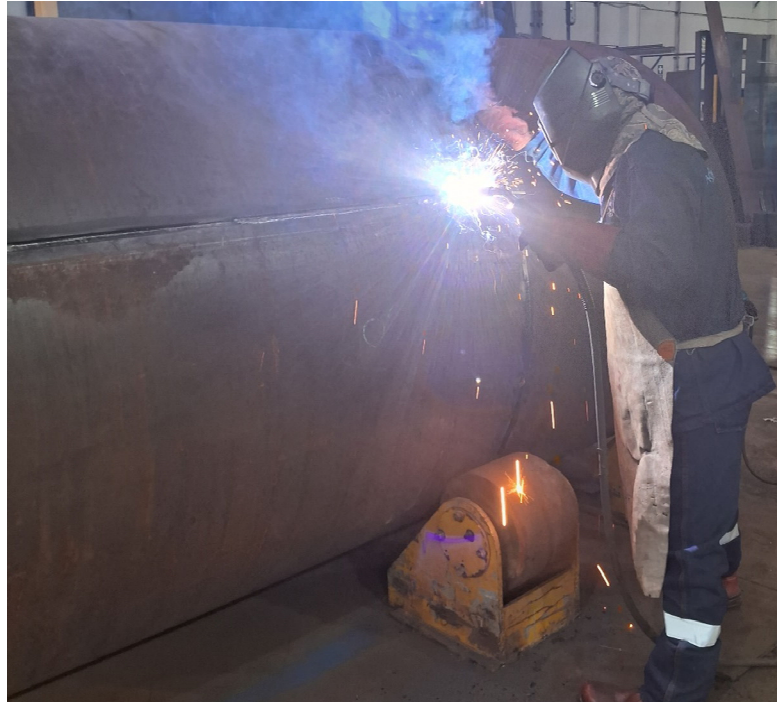
Figura 4.17. Soldadura de carcasa de la caldera
