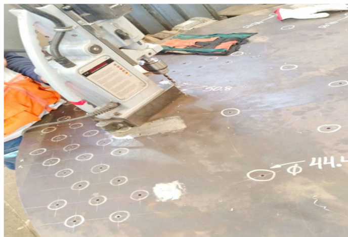
Figura 4.15. perforación de plancha de caldera
