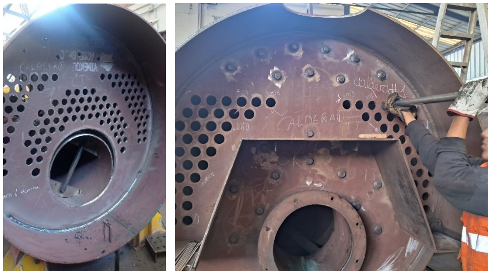
Figura 4.22. Inserción de la placa porta tubos y los tubos a la caldera
