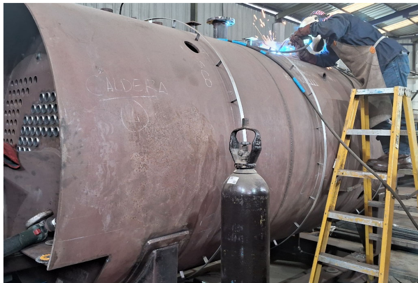
Figura 4.23. Soldadura de accesorios
