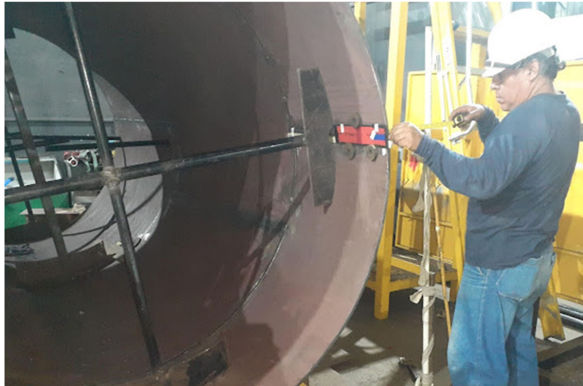
Figura 4.20. Examen Radiográfico a las juntas longitudinales de la caldera
