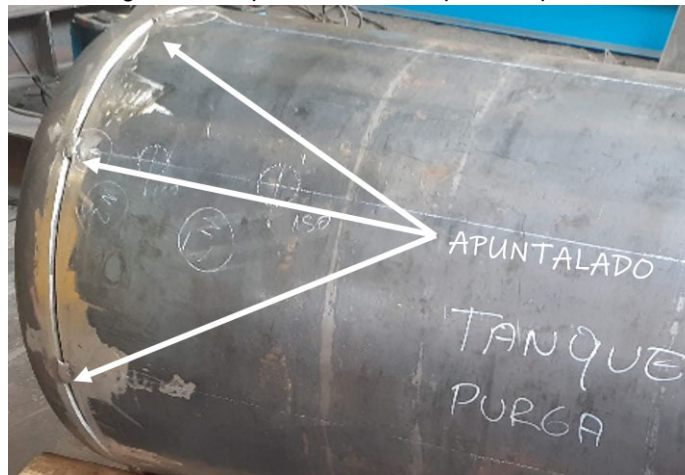
Figura 2.16 Apuntalado de recipiente a presión
