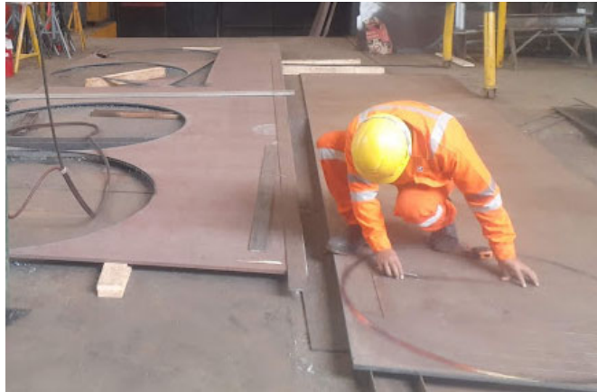
Figura 4.14. Corte de plancha de caldera
