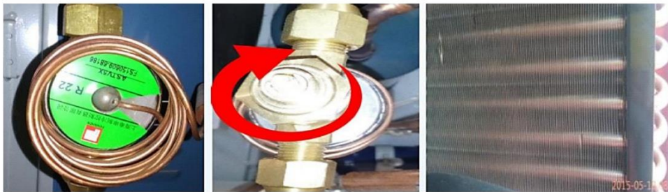
VÁLVULA DE EXPANSIÓN
