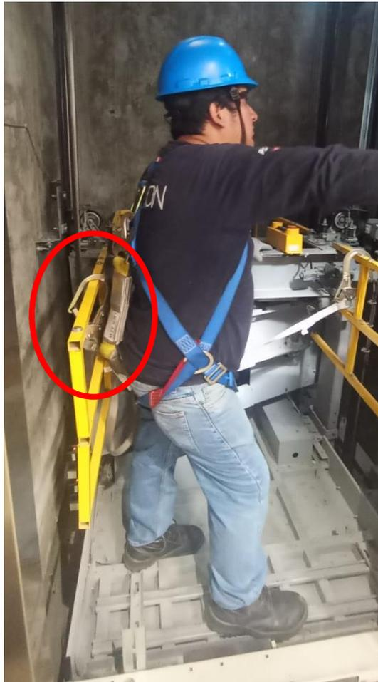
**Figura 08:** Cinturón de restricción en barandas de techo de cabina
