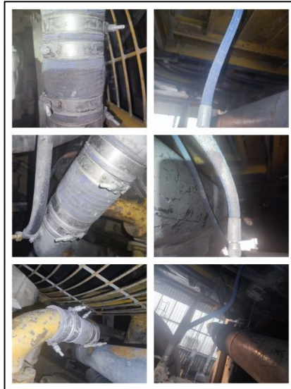
Figura A1. Ajuste e inspección de abrazaderas de sistema de refrigeración.
