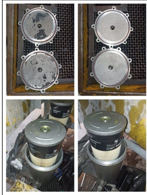
Figura A11. Inspección y cambio de filtros de combustibles
