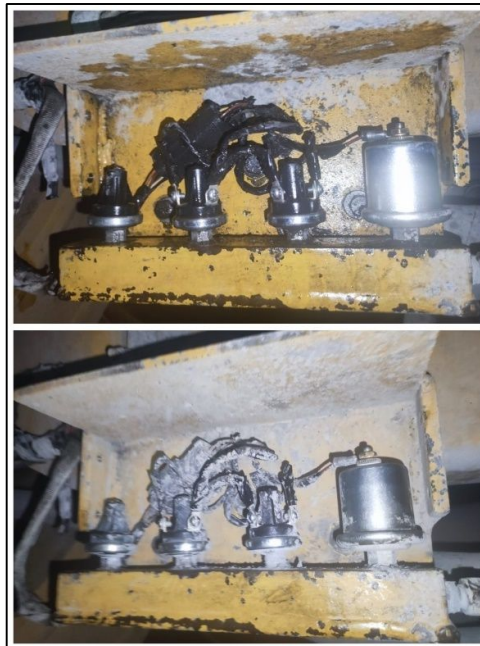
Figura A12. Inspección y limpieza de manifold de aceite
