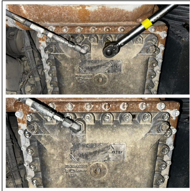
Figura A17. Verificación del torque adecuado de pernos de tapas de CAC.
