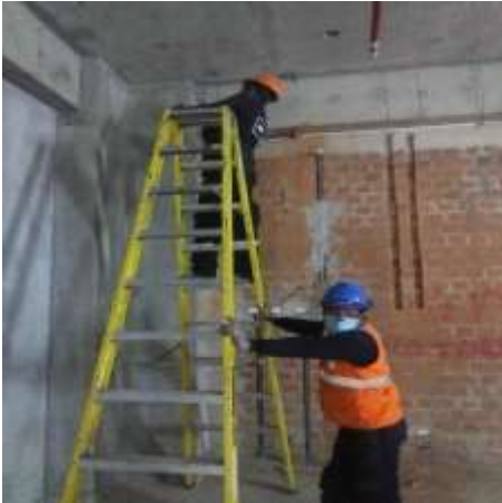
Figura 4. Instalación de soporteria en escalera
