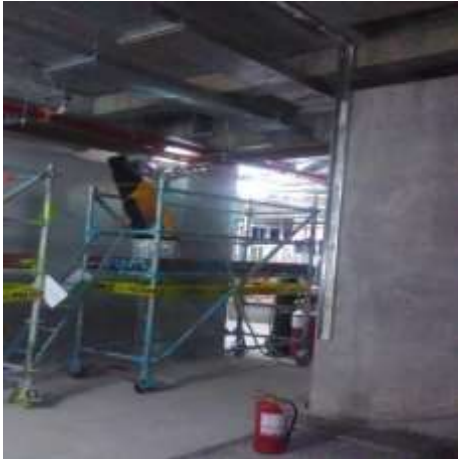
Figura 8. Instalación de tubería de cobre y soldadura
