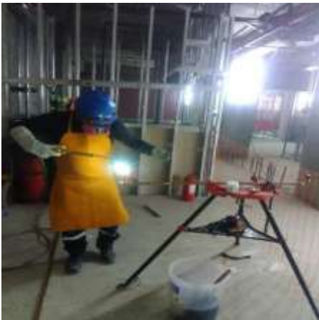
Figura 6. Soldadura de tubería de cobre vista panorámica
