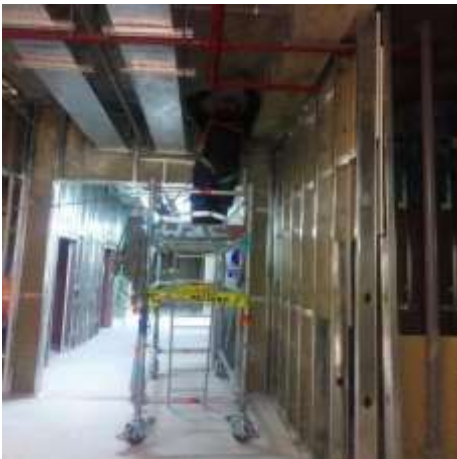
Figura 5. Instalación de soporteria en andamio.
