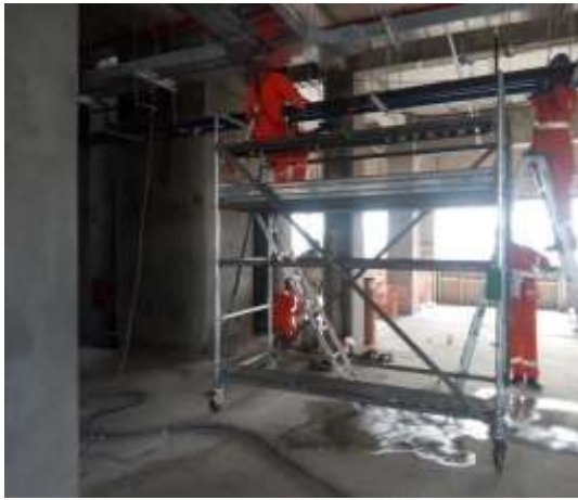
Figura 19. Ejemplo de trabajos en altura.
