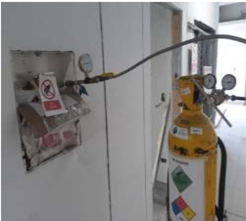
Figura 10. Purga y barrido de tuberías
