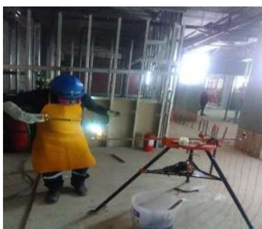
Figura 20. Ejemplo de trabajos en caliente
