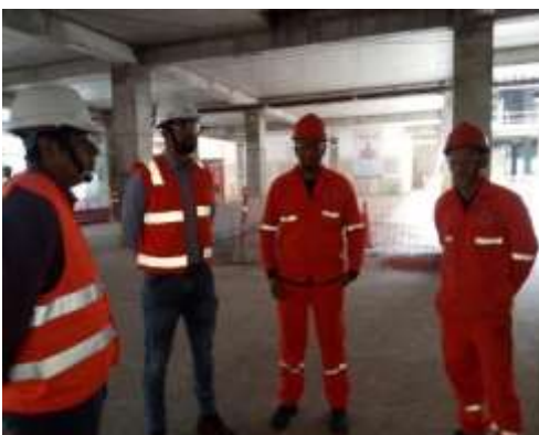
Figura 11. Charla en el inicio de obra
