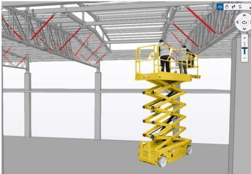
Figura 2.58 Montaje de diagonales con plataforma
