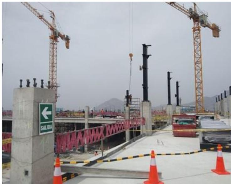
Figura 2.16 Montaje de columnas eje 11
