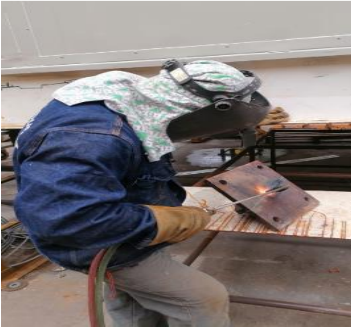
Figura 28. Instalación y soldeo de estructuras en sala eléctrica
