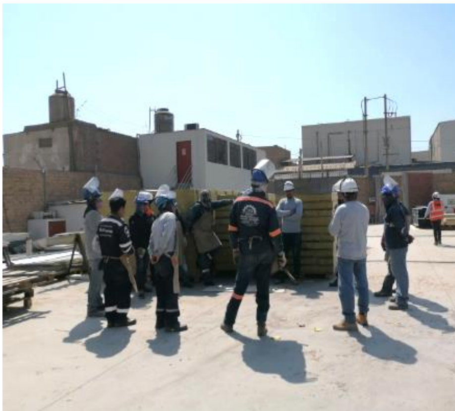
Realización de la charla de seguridad antes del inicio de la jornada
