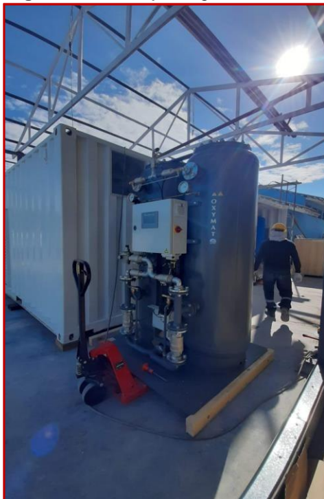
Figura 2.4: Montaje del generador PSA
