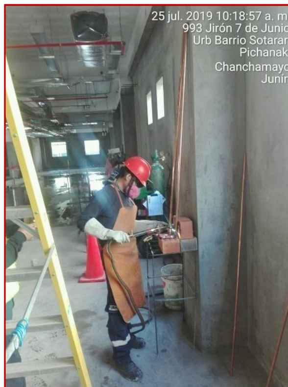
Figura 3.29. Proceso de soldeo
