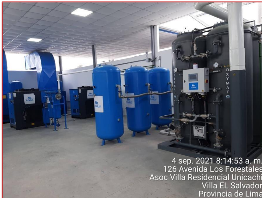
Figura 2.6. Planta de oxígeno medicinal en “Villa Panamericana”
