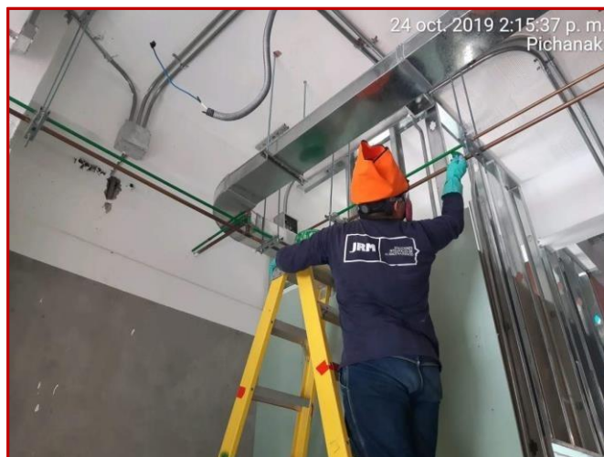
Figura 3.31. Pintado de tubería
