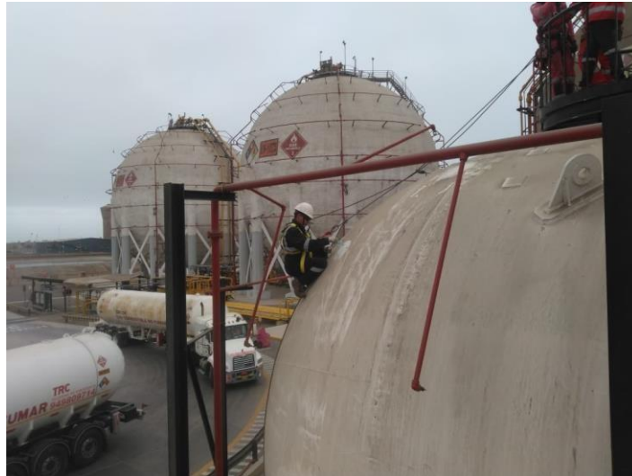
Figura 2.9 Inspección visual externa a recipiente estacionario ubicado en planta industrial de GLP
