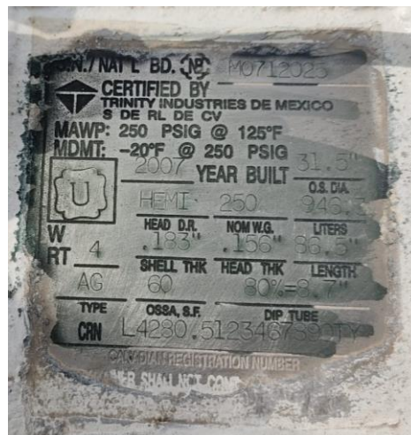
Figura 4.6 Placa de identificación del recipiente M0712025
