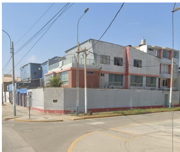
Figura 4.2 Vista panorámica oficinas de la empresa Marconsult Certificaciones S.A.C.
