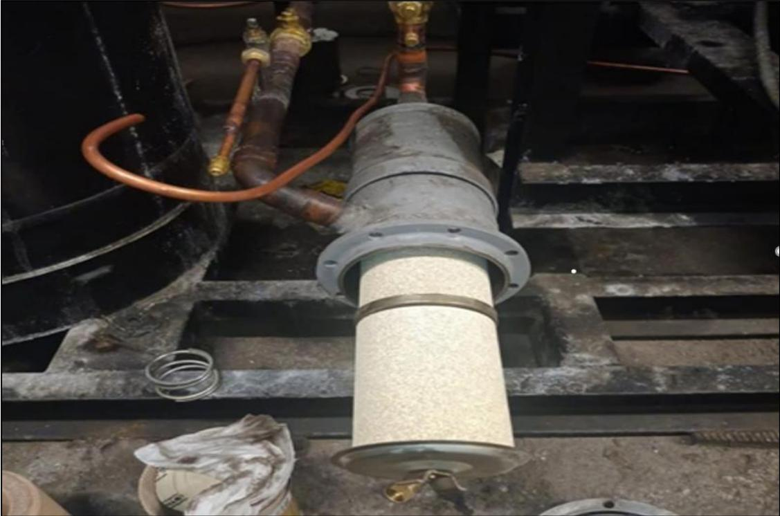
Figura 3.29 Filtro de líquido en el rack de frío
