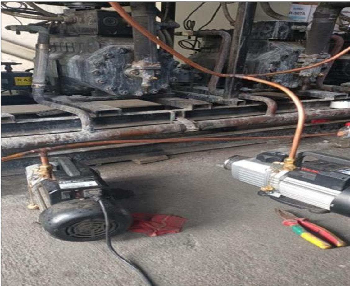
Realización de vacío con bombas en paralelo para extraer el aire y la humedad del sistema, la humedad es propia del aire y los componentes que durante la migración de gas han sufrido hidratación.
