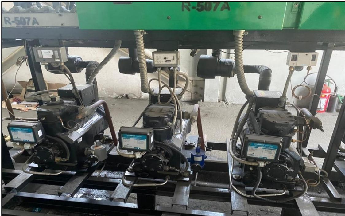
Figura 3.3 Compresores de baja temperatura BT
