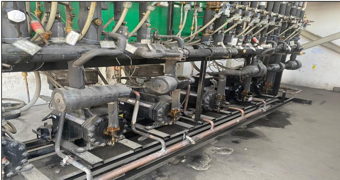
Figura 3.2 Compresores de media temperatura MT
