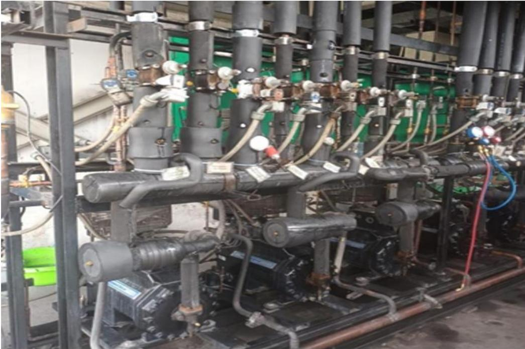
Figura 3.33 Manómetros midiendo presión de vacío
