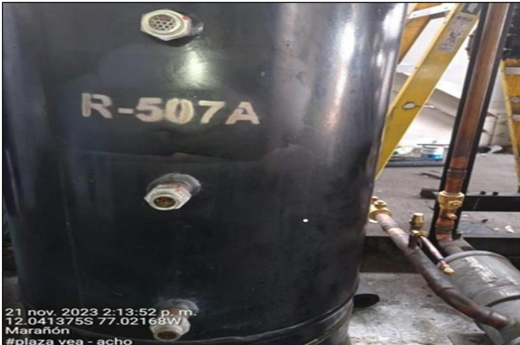
Las instalaciones deben estar señaladas con el gas que está operando actualmente el sistema para evitar confusión y recarga de gas diferente.
