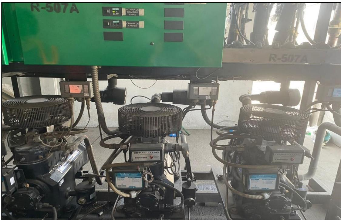
Los compresores de BT tienen un ventilador en el cabezal para optimizar el enfriamiento del equipo.
