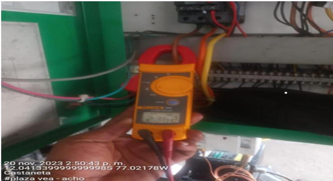
Con una pinza amperimétrica se toma el consumo de corriente por fase del compresor, asimismo el voltaje entre fases.
