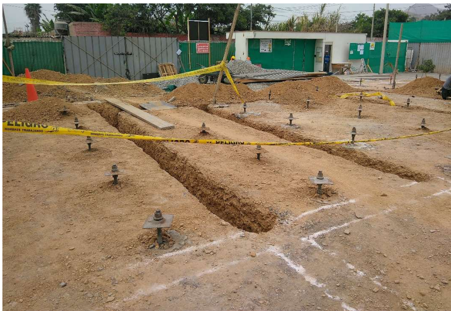
Nota. Se observan pilotes para mejoramiento de suelos.
