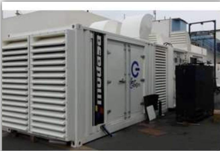
Figura 3.56: Pruebas de Lluvia y Carga
