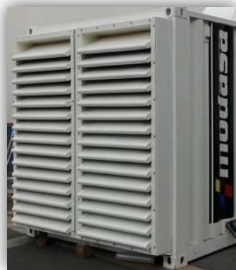
Figura 3.47: Rejillas acústicas salida de aire
