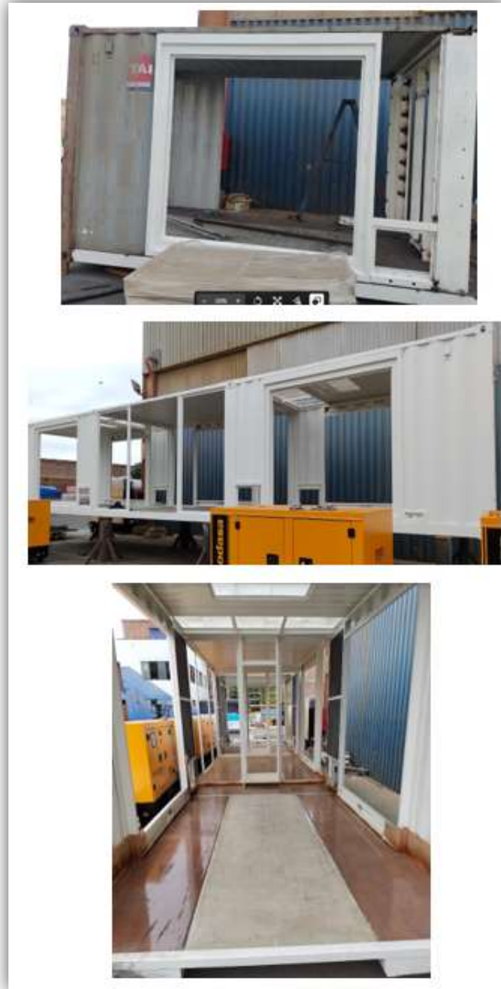
Figura 3.32: Acondicionamiento de Contenedor de 40 Pies Estándar
