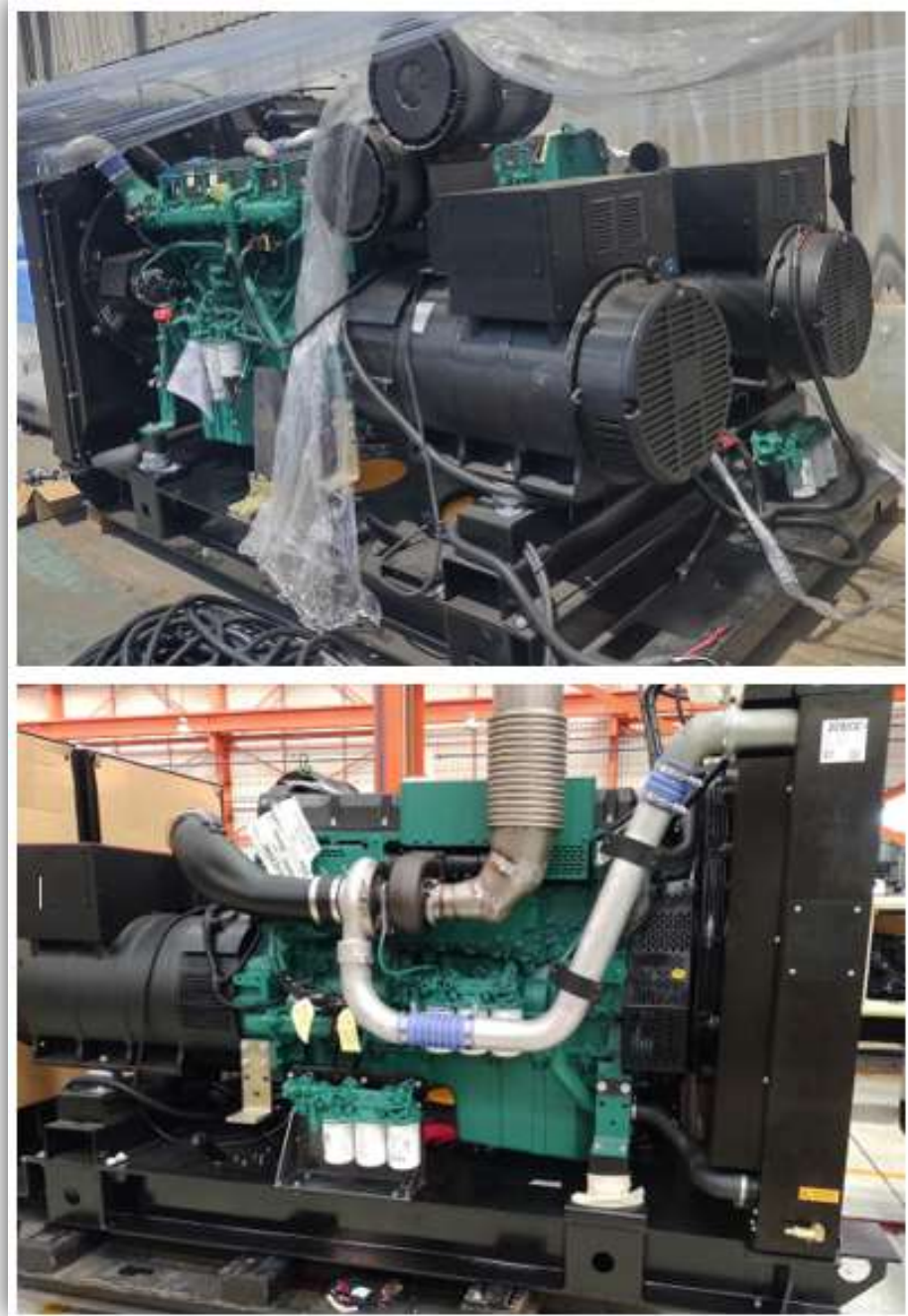
Figura 3.16: Montaje de Grupos sobre Tanque Bastidor
