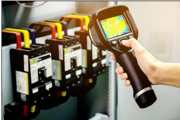
Figura 2.5 Medición de temperatura en equipos eléctricos
