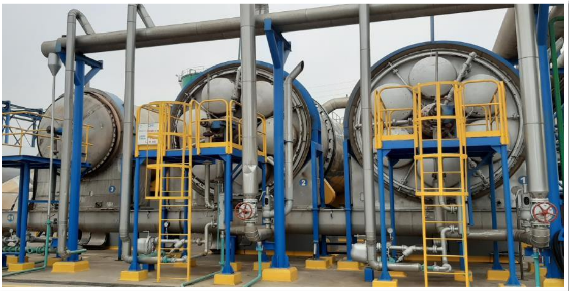
Figura 15. Secador Rotatubos, Planta TASA Végueta.
