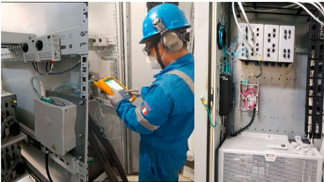
Figura 17. Instalación de cable de Fibra óptica a tablero de Analizador
