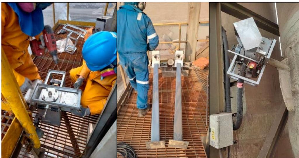
Figura 23. Instalación de la sonda de muestreo
