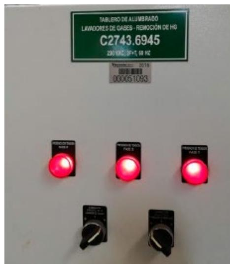
Figura 9. Tablero de alumbrado – Lavadores de Gases
