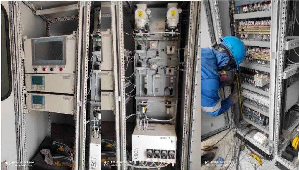
Figura 15. Instalaciones eléctricas de alimentación de Tablero de Analizador SO<sub>2</sub> p1
