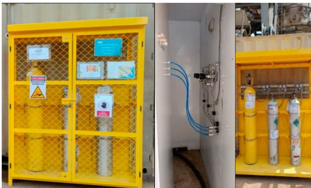
Figura 19. Fabricación de jaula para balones
