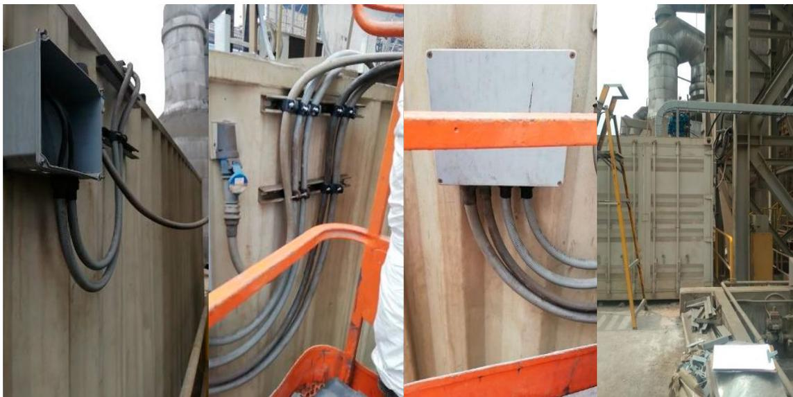
Figura 7. Proceso de habilitación eléctrica de Shelter de servicios auxiliares
