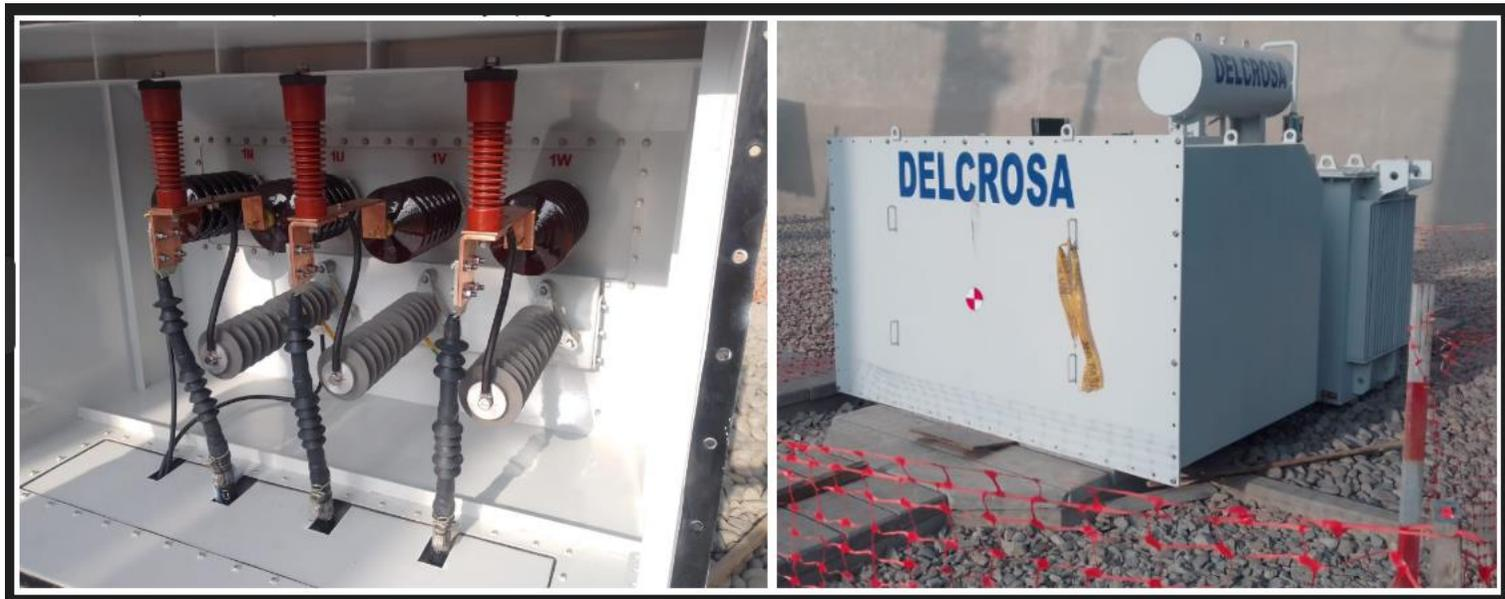
**Anexo N°41. Transformador zigzag cargable en campo (SUBESTACION LA PLANICIE) III**
