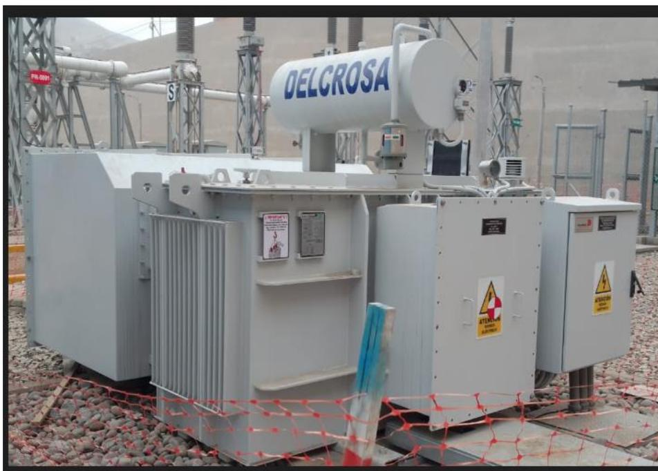
**Anexo N°40.** Transformador zigzag cargable en campo (SUBESTACION LA PLANICIE) II
