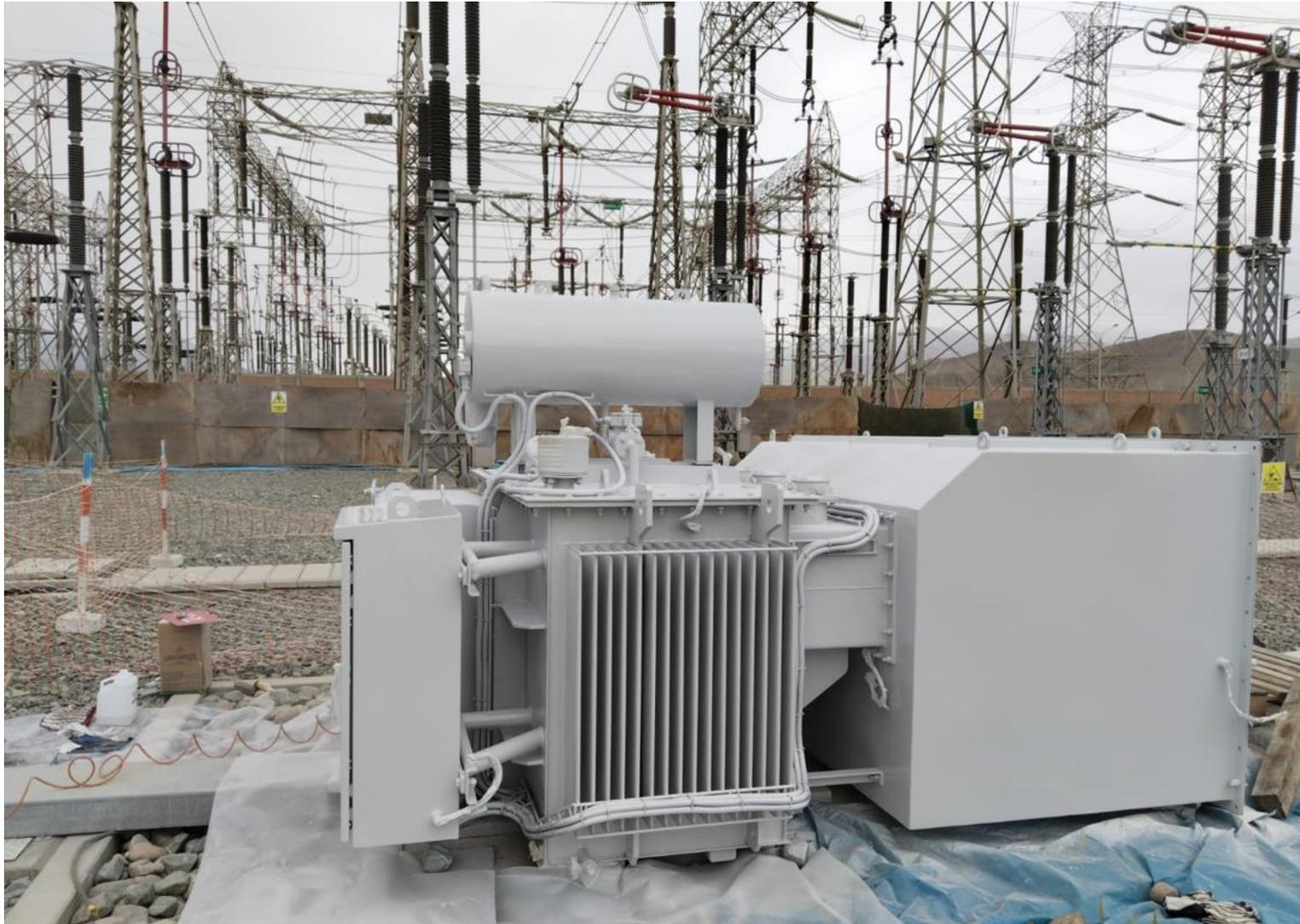
**Anexo N°42. Transformador zigzag cargable en campo (SUBESTACION LA PLANICIE) IV**
